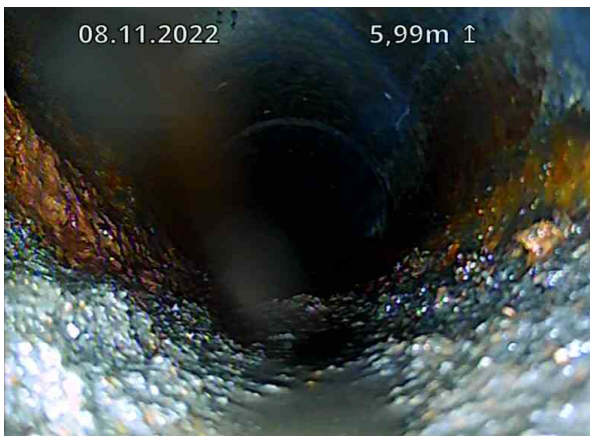
OV Bunnledning 2_Gulvluke 3_STPOV1_08112022_080106_007.jpg, 00:01:13, 5.99m Tilkobling. Prefabrikkert grenrør på 10 Kl. / TKP 11
