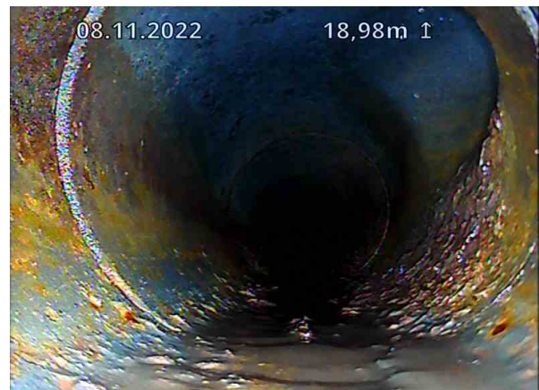
OV Bunnledning 2_Gulvluke 3_STPOV1_08112022_080106_008.jpg, 00:03:07, 18.98m Tilkobling. Prefabrikkert grenrør på 2 Kl. / TKP 18
