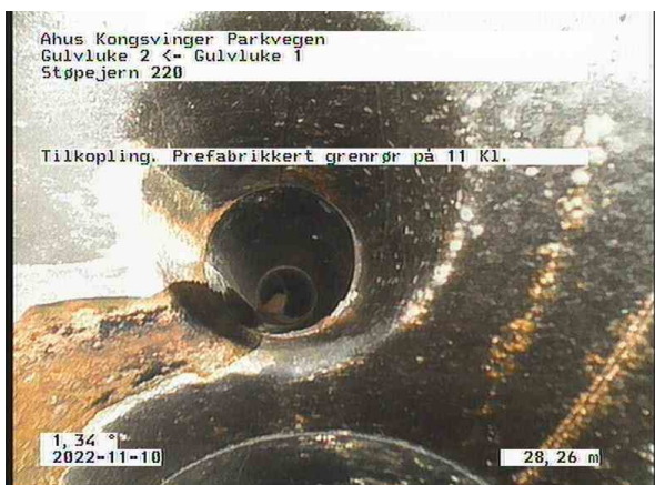
OV Bunnledning 5_Gulvluke 2_Gulvluke 1_10112022_101420_027.jpg, 00:05:38, 28.26m Tilkobling. Prefabrikkert grenør på 11 Kl., 100mm / TKP37
