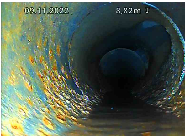
OV Bunnledning 3_STPOV1_DE2_09112022_080450_012.jpg, 00:02:05, 8.82m Tilkobling. Prefabrikkert grennrør på 2 Kl. / TKP 22
