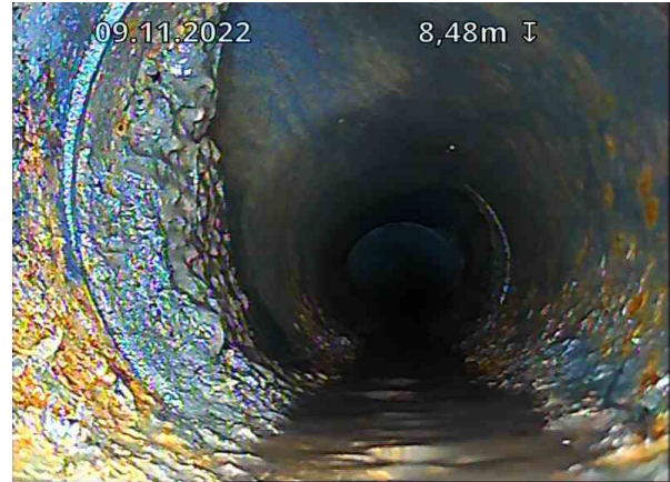
OV Bunnledning 3_STPOV1_DE2_09112022_080450_011.jpg, 00:01:42, 8.48m Tilkobling. Prefabrikkert grennrør på 10 Kl. / TKP 30
