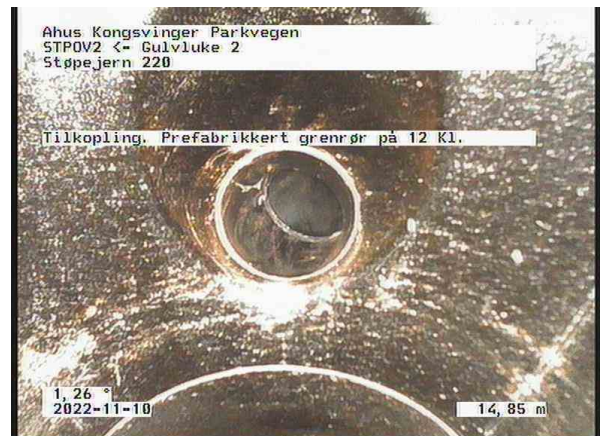
OV Bunnledning 4_DE2_Gulvluke 2_10112022_102637_017.jpg, 00:03:32, 14.85m Tilkopling. Prefabrikkert grenrør på 12 Kl. / STPOV2?
