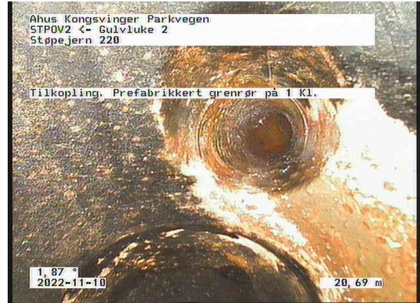
OV Bunnledning 4_DE2_Gulvluke 2_10112022_102637_019.jpg, 00:04:44, 20.69m Tilkobling. Prefabrikkert grenrør på 1 Kl. / TKP 55
