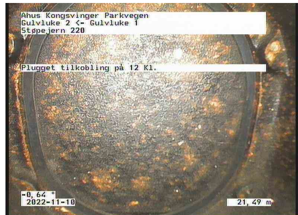
OV Bunnledning 5_Gulvluke 2_Gulvluke 1_10112022_101420_026.jpg, 00:04:35, 21.49m Plugget tilkobling på 12 Kl. / ikke funnet gulvluke? mulig støpt igjen?
