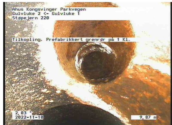
OV Bunnledning 5_Gulvluke 2_Gulvluke 1_10112022_101420_024.jpg, 00:02:33, 9.87m Tilkopling. Prefabrikkert grenrør på 1 Kl. / TKP 70
