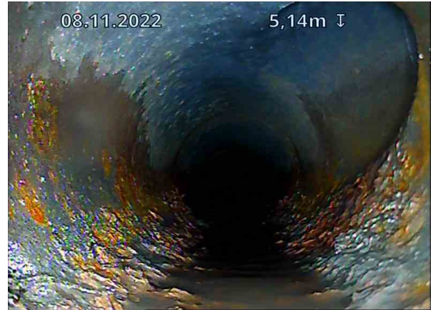
OV Bunnledning 2_Gulvluke 3_STPOV1_08112022_080106_006.jpg, 00:00:53, 5.14m Tilkobling. Prefabrikkert grenrør på 2 Kl. / TKP 17
