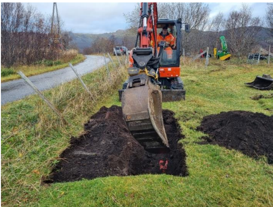
Figur 2-14. Fra graving av prøvesjakt P11, masser under oljefylt høyspentkabel. Foto: Multiconsult
