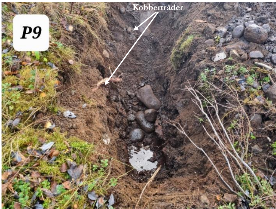
Figur 2-11. Fra prøvesjakt P9 utenfor Senderbygget hvor det ble registrert lukt av oljeforbindelser. Bildet viser også rester av kobbertråder. Foto: Multiconsult.
