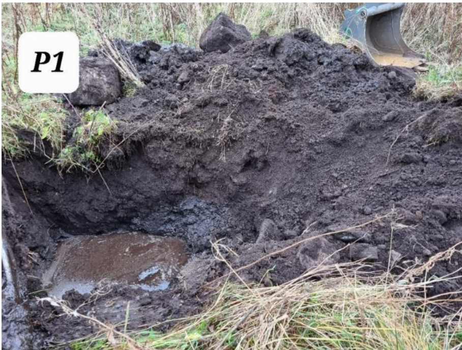
Figur 2-5. Fra prøvesjakt P1 bak garasjebygg/verksted hvor det ble registrert svak oljelukt i masser fra ca. 1 meter under terrengoverflaten. Foto: Multiconsult.
