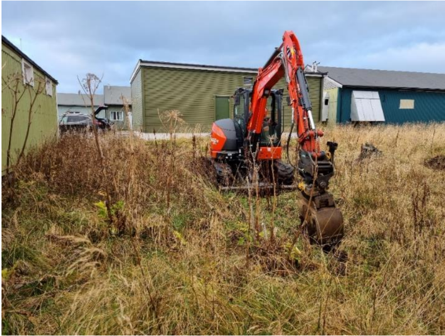
Figur 2-4. Fra graving av prøvesjakter bak verksted/garasjebygg. Foto: Multiconsult.
