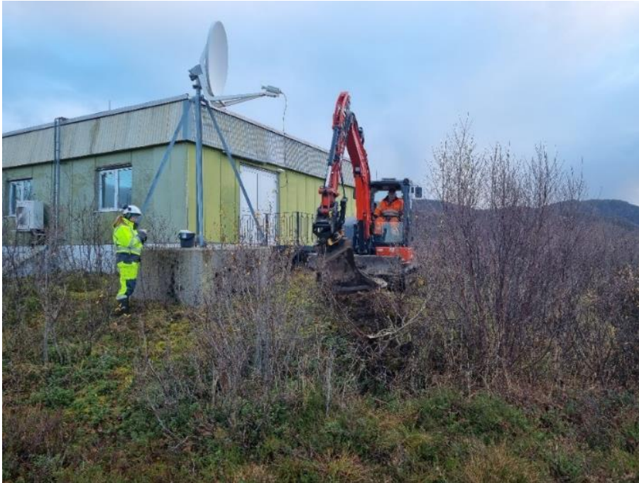
Figur 2-10. Fra graving av prøvesjakt P9 vest for senderbygget. Foto: Multiconsult.
