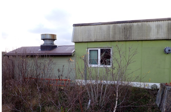
Figur 31 Senderbyggets fasade mot nordøst.
