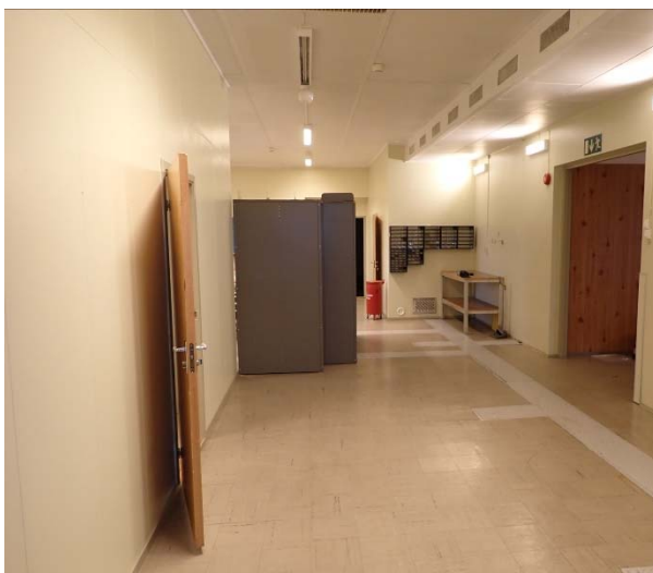
Figur 20 Gangareal i elektronikkbygget. På gulvet er det vinylfliser.
