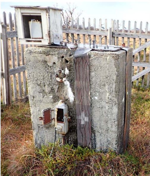
Figur 42 Betongfundament med elektriske koblinger/bokser. Fundamentet har tilhørt én av lyttemastene.
