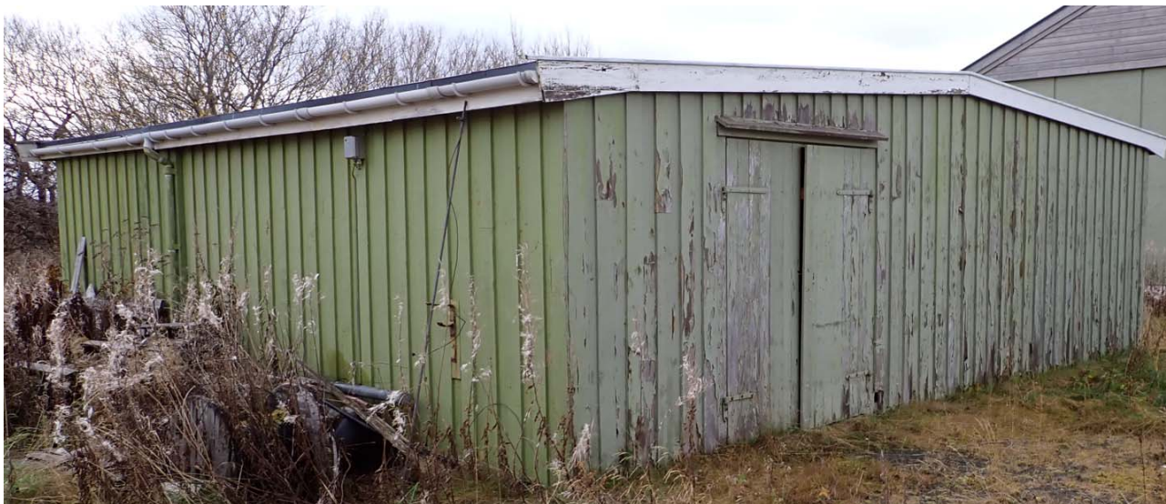
Figur 11 Snekkerverkstedets fasade mot nordøst, og mot nordvest (med dør).
