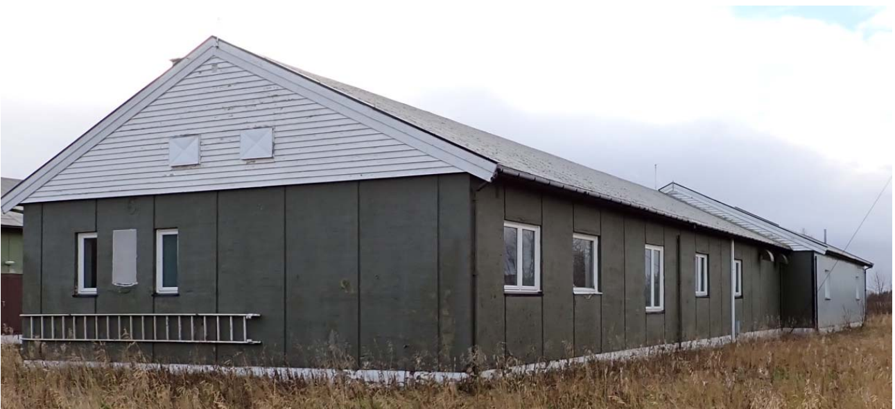
Figur 17 Elektronikkbyggets fasade mot nordøst og nordvest.
