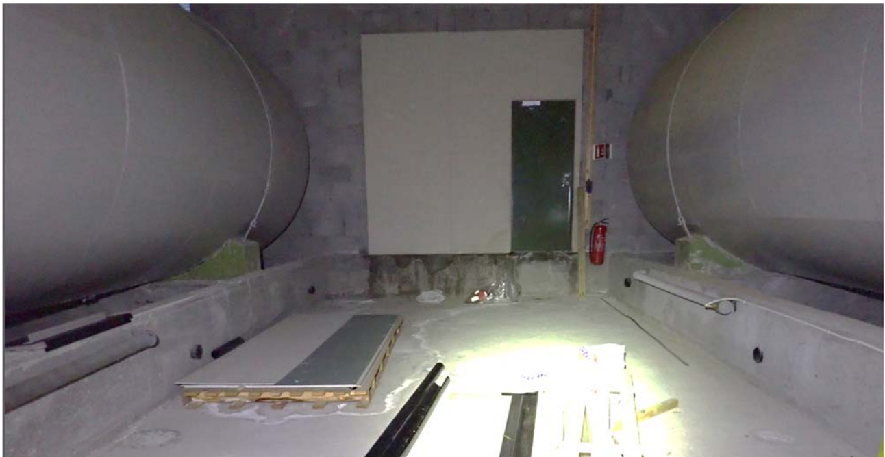
Figur 10 Dieseltankene (2 stk a 45 m 3 ) inni tankbygget.
