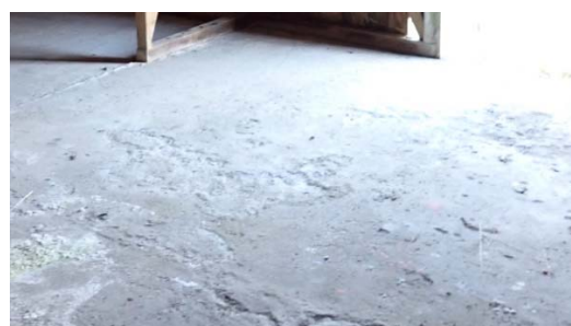
Figur 57 Betonggulv i garasjen (prøve S1).
