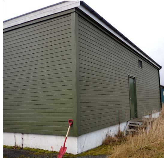
Figur 9 Tankbyggets fasade mot sørvest, og mot sørøst (med dør).
