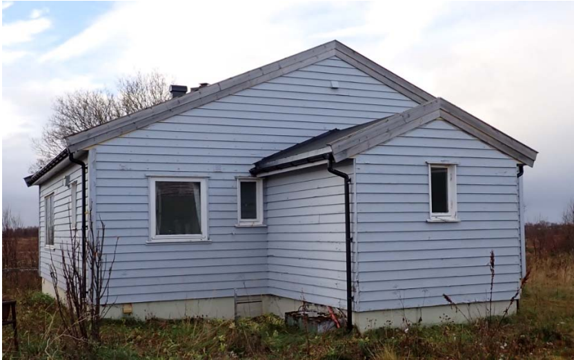
Figur 35 Bungalowens fasade mot nordvest og sørøst. Bygningen er vernet utvendig og innvendig, og er ikke kartlagt.
