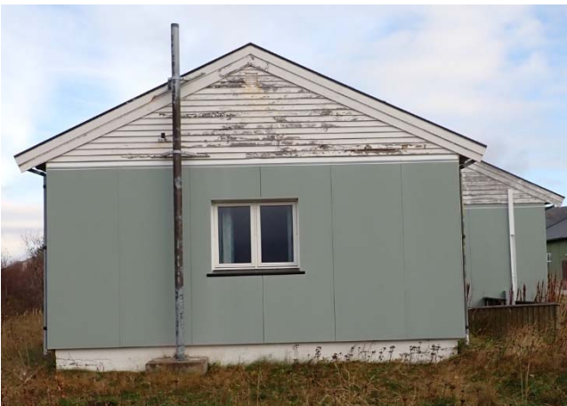
Figur 16 Elektronikkbyggets fasade mot sørvest.
