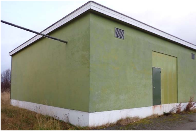
Figur 8 Tankbyggets fasade mot nordøst, og mot nordvest (med dør).
