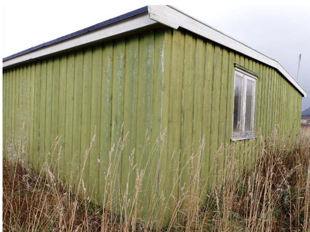
Figur 12 Snekkerverkstedets fasade mot sørvest, og mot sørøst (med vindu).
