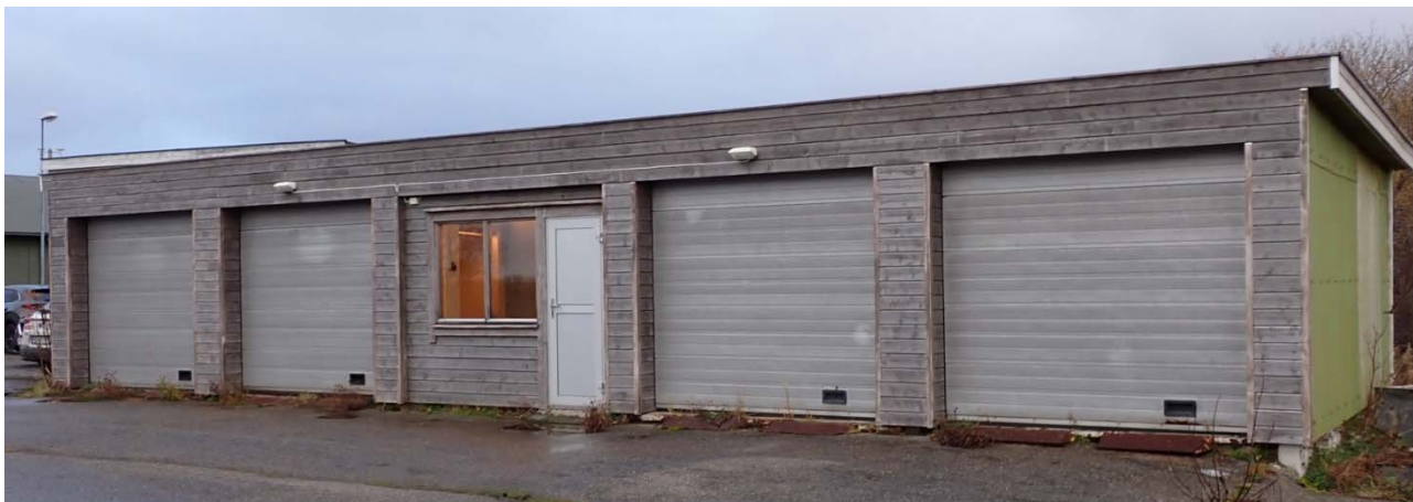
Figur 4 Foto av sørvest-fasade, og sørøst-fasade (grønnfarget side til høyre), på garasje.
