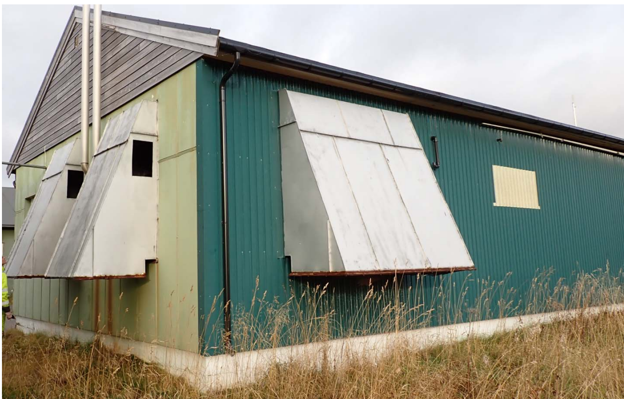
Figur 27 Sørvestre fasade (til venstre) og sørøstre fasade på reservekraftbygget.
