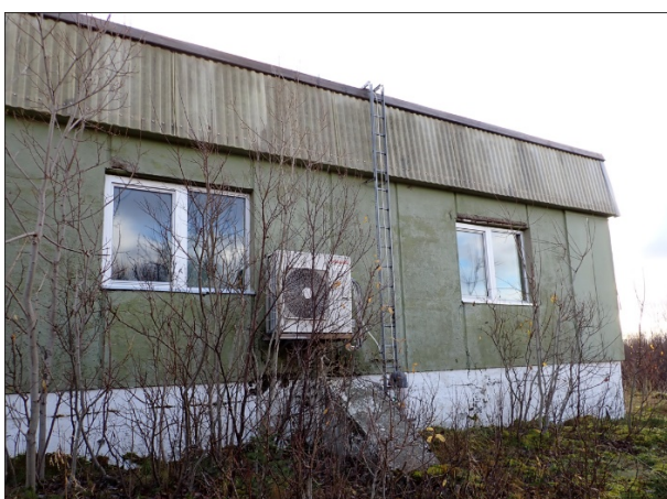
Figur 32 Senderbyggets fasade mot nordvest.
