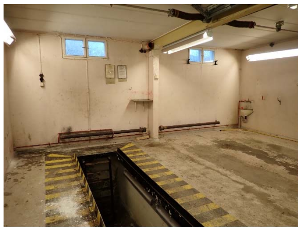
Figur 7 Verksted med smøregrav, sørøst i garasjen.
