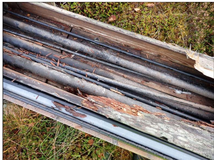
Figur 37 Diverse kabler inni kabelgaten.
