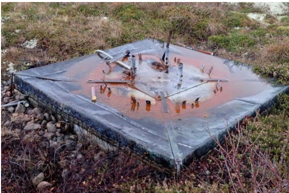
Figur 40 Eksempel på betongfundament med metallbeslag, delvis over terreng.
