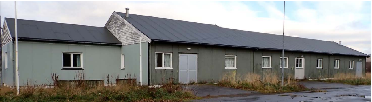
Figur 15 Elektronikkbyggets fasade mot sørøst. Bygningen er vernet og kun delvis kartlagt.
