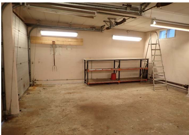
Figur 6 Verksted nordvest i garasjen.
