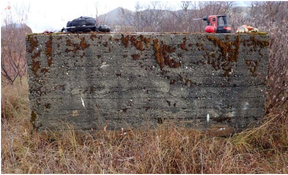
Figur 38 Eksempel på betongfundament delvis over terreng.
