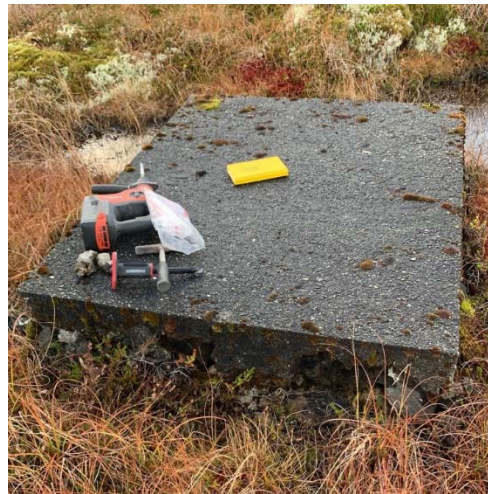
Figur 41 Eksempel på betongfundament delvis over terreng.
