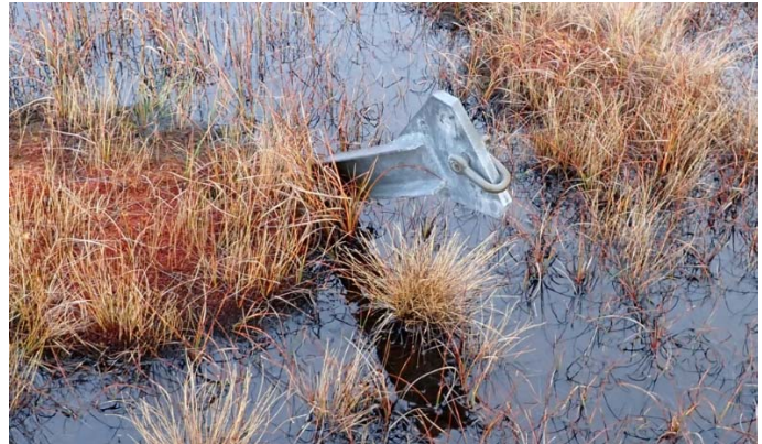
Figur 39 Metallfeste som antas å være festet til et betongfundament (eller til berg) under vann/nede i myra.
