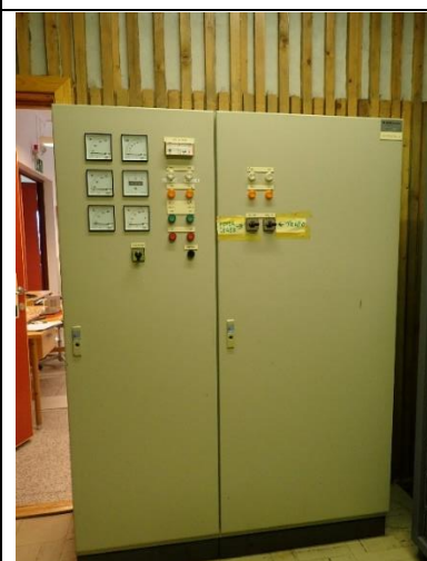
Figur 24 Styringskap som skal fjernes
