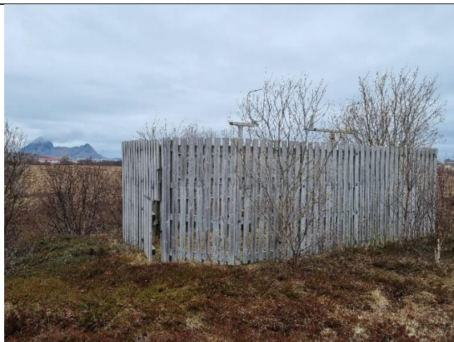
Figur 38 Impregnert gjerde nord for Senderbygg (markert med P39 i Figur 37). Skal fjernes.
