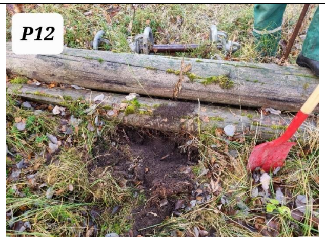
Figur 36 Stolper på tidligere lagerplass som skal fjernes
