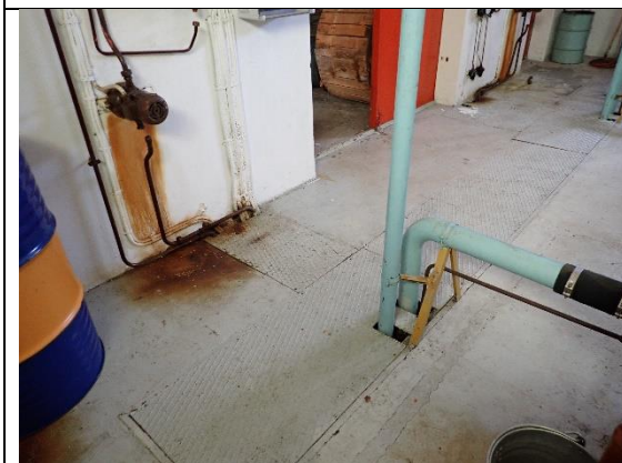
Figur 18 Alt av rørføring og kabler til tekniske installasjoner fjernes. Gjelder også utstyr i kabelgater i gulv.
