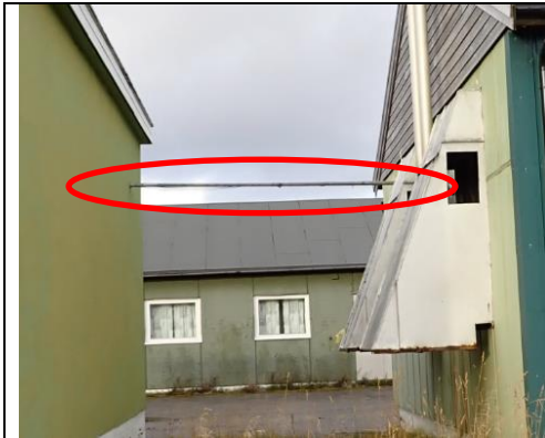
Figur 9 Rør mellom Reservekraftbygget (til høyre) og Tankbygget (til venstre) som skal stå igjen (plassering vist ved rød sirkel).
