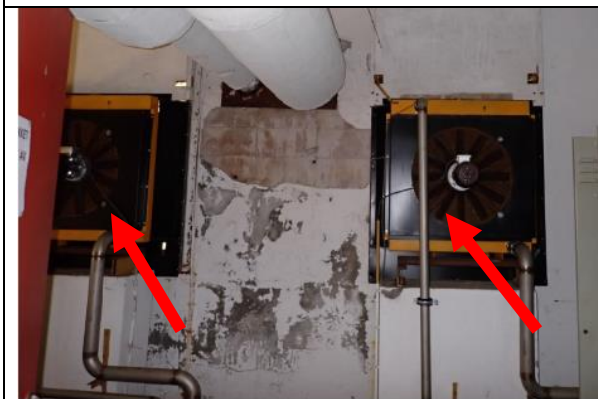
Figur 11 Ventiler/vifter som står i yttervegg med tilhørende rør fjernes.
