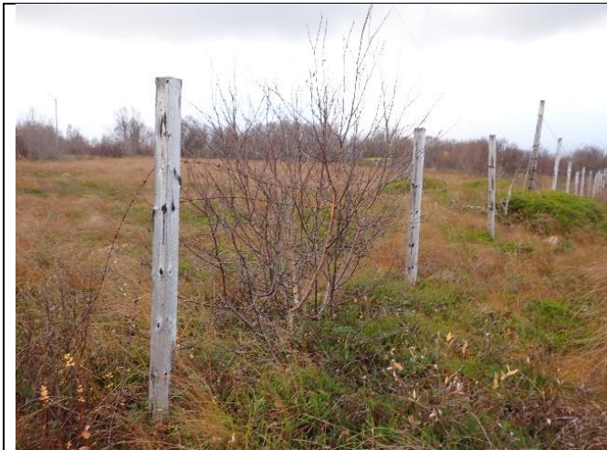
Figur 33 Impregnerte gjerdestolper rundt tomte skal fjernes
