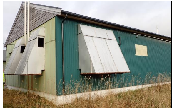
Figur 10 Fasade på Reservekraftbygget. Hetter og eksosgassrør skal stå igjen.
