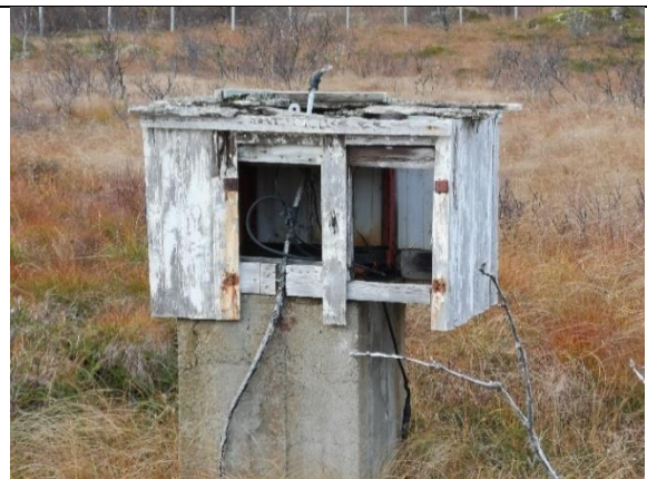
Figur 47 Fundament med treboks og kabler
