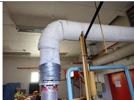
Figur 15 Røykgassrør som går fra aggregat.
