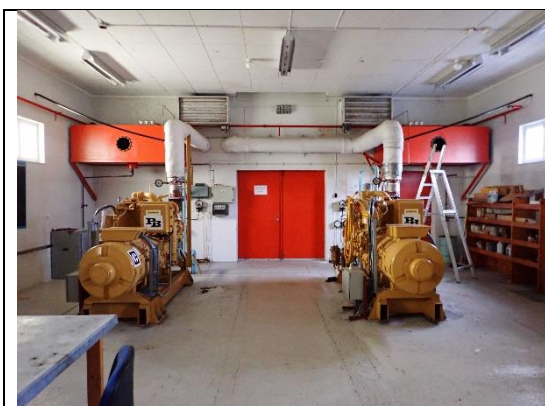
Figur 16 Aggregater og dagtanker, etc. skal fjernes.
