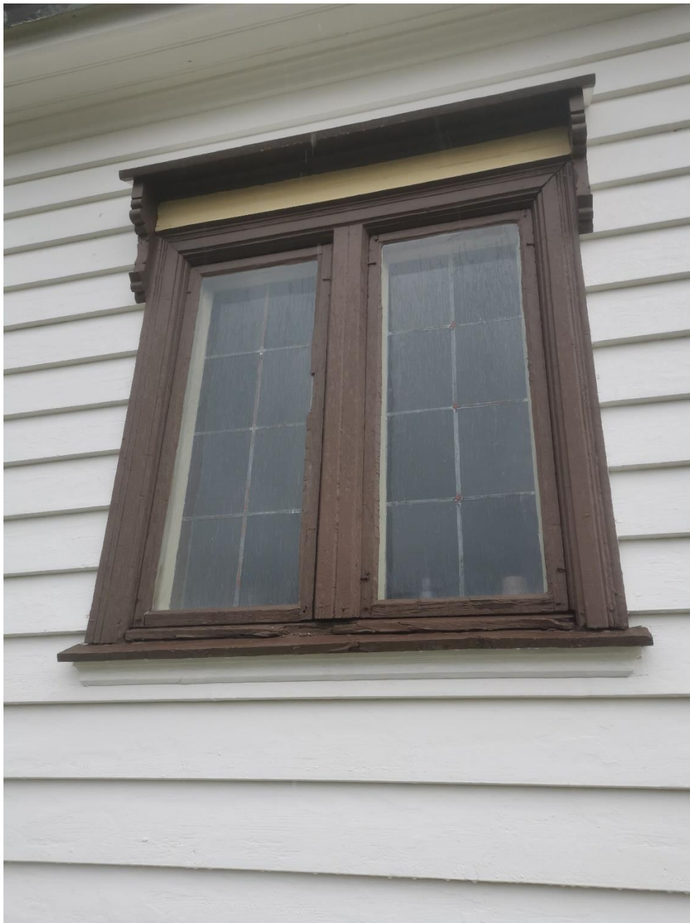
Figur 4 Vindu i sakristiet, vannesen må skiftes, rammen repareres. Bilde: Helge Kleemann
