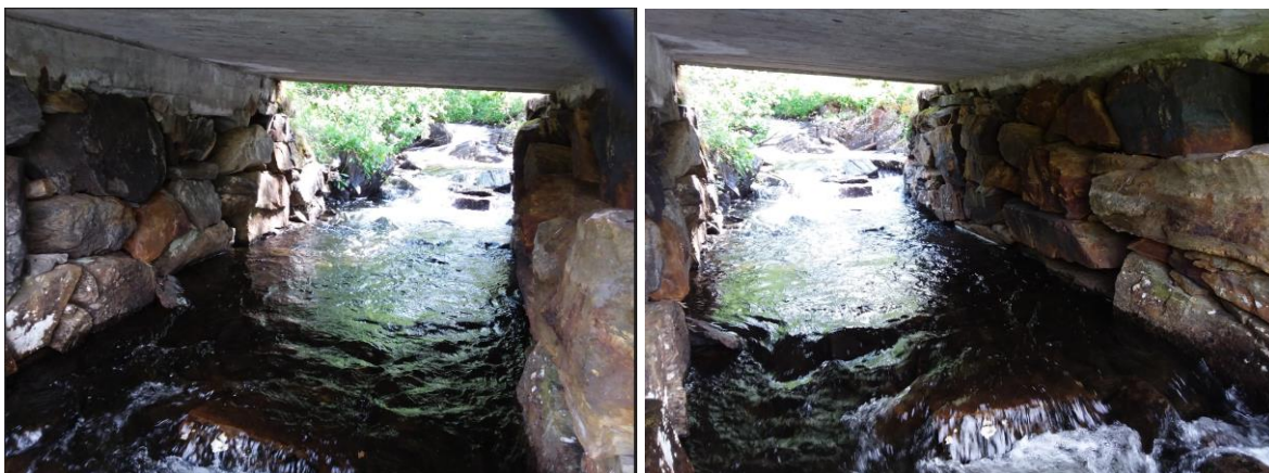
Bilde 6-2. Tatt fra utløpet og mot innløpet. Kilde: Brutus.
