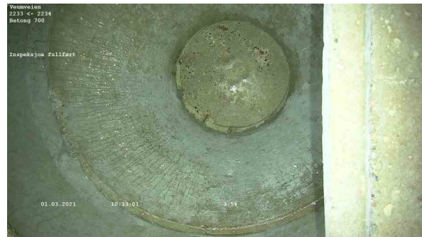
25601_2233_2234_Veumveien_010321_101018_037.jpg, 00:02:21, 29.60m Inspeksjon fullført
