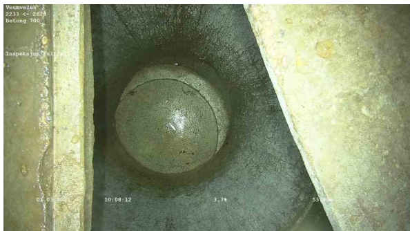
25602_2233_2820_Veumveien_010321_100036_035.jpg, 00:00:09, 53.90m Inspeksjon fullført
