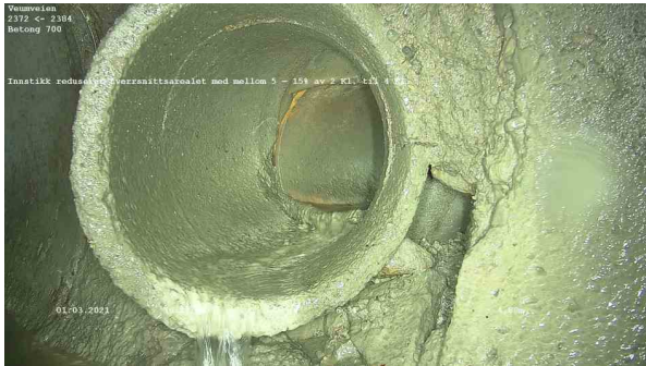
25610_2372_2384_Veumveien_010321_102204_042.jpg, 00:00:36, 4.80m Innstikk reduserer tverrsnittsarealet med mellom 5 – 15% av 2 Kl. til 4 Kl.
