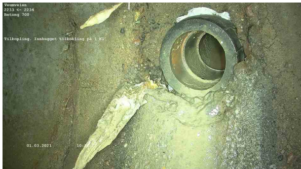
25601_2233_2234_Veumveien_010321_101018_036.jpg, 00:00:58, 8.10m Tilkobling. Innhugget tilkobling på 1 Kl.
