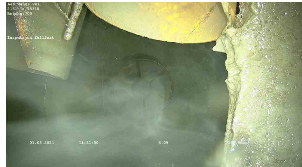
25609_2131_78318_Aas Wangs vei_010321_111533_059.jpg, 00:12:15, 145.90m Inspeksjon fullført
