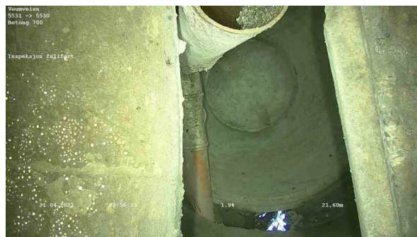
14_5531_5530_Veumveien_210421_075303_063.jpg, 00:02:30, 21.60m Inspeksjon fullført
