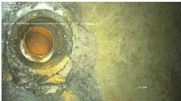
25607_2795_2131_Aas Wangs vei_010321_110810_048.jpg, 00:02:06, 19.00m Innsjikt reduserer tverrsnittsarealet med 5 % eller mindre på 11 Kl.
