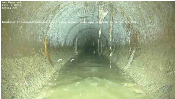
25609_2131_78318_Aas Wangs vei_010321_111533_050.jpg, 00:00:39, 4.00m Reduksjon av tverrsnittsarealet er 5 % eller mindre, enkle fine rottråder av 12 Kl. til 2 Kl.
