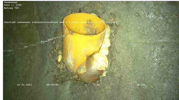
25606_2819_2795_Veumveien_010321_094413_026.jpg, 00:03:23, 34.10m Innstikk reduserer tverrsnittsarealet med 5 % eller mindre av 12 Kl. til 1 Kl.
