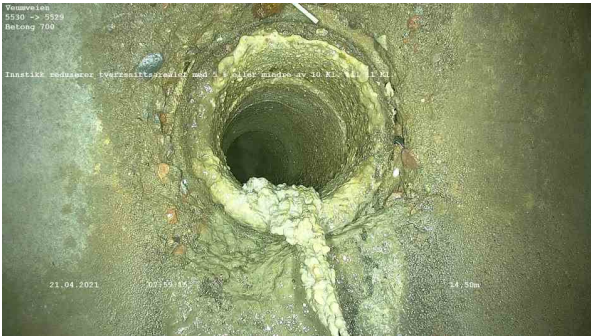
26066_5530_5529_Veumveien_210421_075810_064.jpg, 00:01:00, 14.50m Innstikk reduserer tverrsnittsarealet med 5 % eller mindre av 10 Kl. til 11 Kl.
