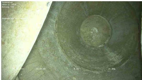
25605_2820_2819_Veumveien_010321_095355_032.jpg, 00:03:29, 35.40m Inspeksjon fullført
