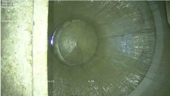
25600_2234_2235_Veumveien_010321_101455_038.jpg, 00:01:26, 17.10m Inspeksjon fullført
