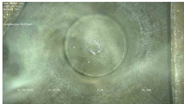
25607_2795_2131_Aas Wangs vei_010321_110810_049.jpg, 00:03:29, 34.20m Inspeksjon fullført
