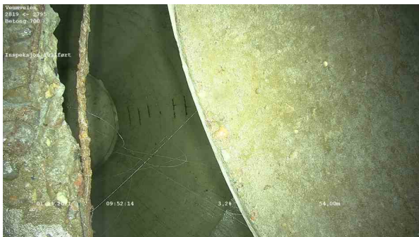
25606_2819_2795_Veumveien_010321_094413_027.jpg, 00:04:45, 54.00m Inspeksjon fullført
