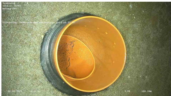
22641_3355_70162_Veumveien_020221_102428_011.jpg, 00:11:09, 166.20m Tilkopling. Sadelgren med kjerneboret hull på 11 Kl.
