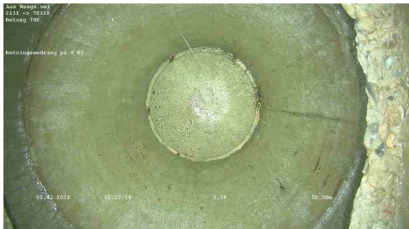
25609_2131_78318_Aas Wangs vei_010321_111533_054.jpg, 00:04:21, 52.50m Retningsending på 9 Kl. / Kum ikke på kart
