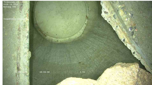
26067_5529_5528_Veumveien_210421_080230_067.jpg, 00:02:05, 28.10m Inspeksjon fullført
