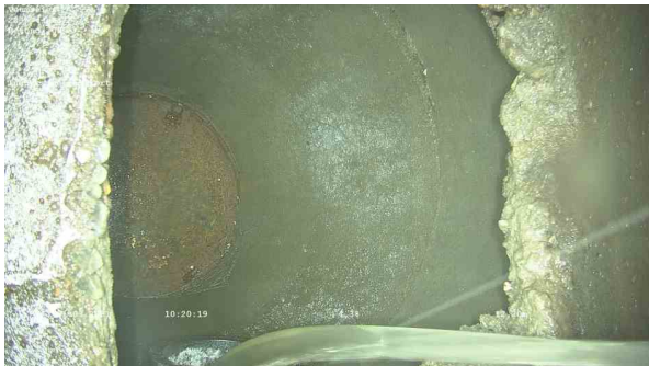
25589_2235_2372_Veumveien_010321_101747_041.jpg, 00:01:44, 12.20m Inspeksjon fullført
