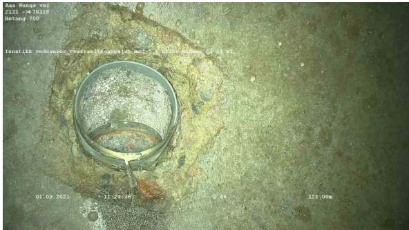
25609_2131_78318_Aas Wangs vei_010321_111533_058.jpg, 00:10:12, 121.00m Innstikk reduserer tverrsnittsarealet med 5 % eller mindre på 11 Kl.
