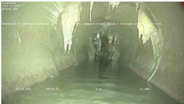
25837_2352_2282_Sandveien_210421_092847_084.jpg, 00:01:43, 22.40m Reduksjon av tverrsnittsarealet er 5 % eller mindre, sammenfiltrede røtter / rottugge av 10 Kl. til 2 Kl.
