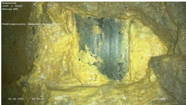
22641_3355_70162_Brønnerød_020221_090048_006.jpg, 00:24:04, 277.00m Punktreparasjon. Reparert hull på 3 Kl.
