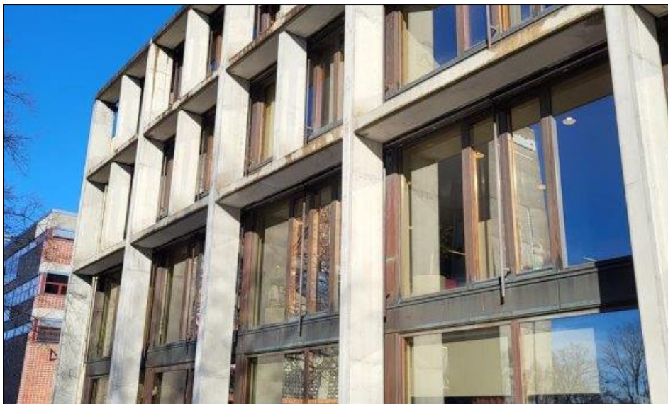
Figur 2: Bilde av bygget tatt på befaring.
