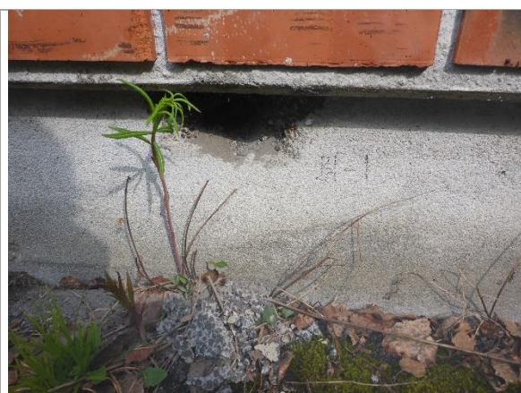
Bilde 22: Grunnmuren på Tjoreputten Bygg 1, med ringmur av pusset leca.
