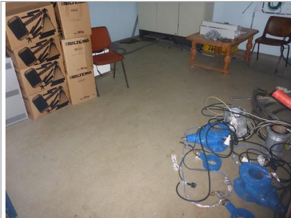
Bilde 3: Bygg 1, innvendig 1.etasje.
