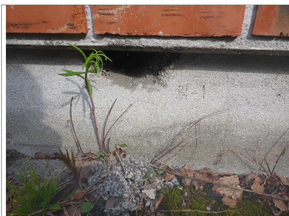
Bilde 9: Bygg 1 Grunnmur - Murpuss på leca 1 (prøvested B1-1)
