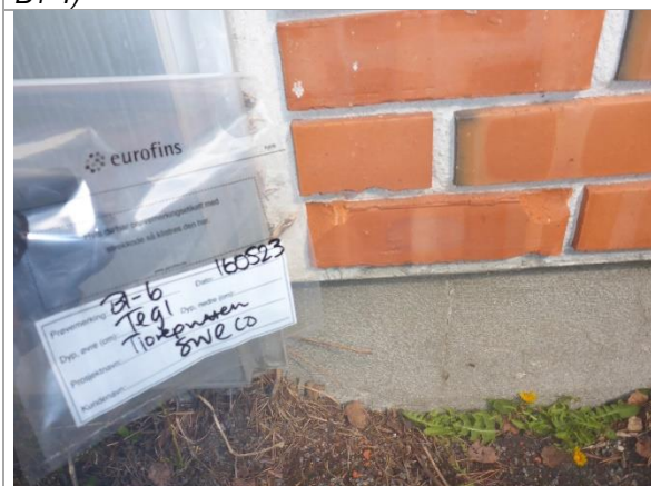
Bilde 13: Bygg 1 Yttervegg tegl (prøvested B1-6)
