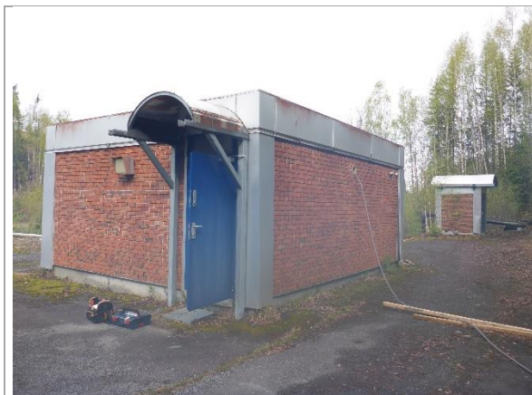
Bilde 1: Bygg 1 – Tjoreputten pumpestasjon pumpehus hovedinntak, bygget ca. 1986
