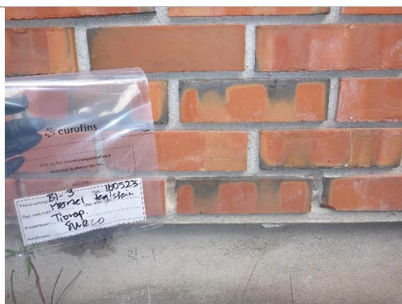
Bilde 10: Bygg 1 Vegg – Mørtel mellom teglstein (prøvested B1-3)
