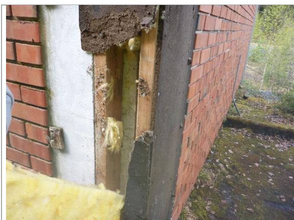
Bilde 7: Prøve fra Bygg 1 – Isolasjonsmateriale i yttervegg
