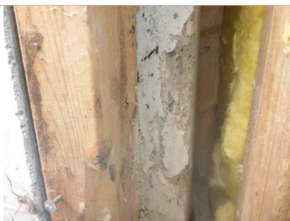
Bilde 23: Bilde fra utvendig hjørne Bygg 1. Betongsøyler i hjørnene, isolert mot yttervegg med glava.
