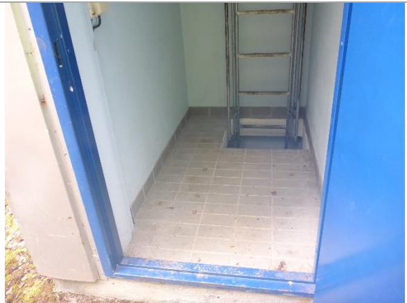
Bilde 4: Bygg 2, innvendig overbygg.
