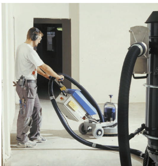
Fig. 40: Gulvsliping med påmontert avsug
