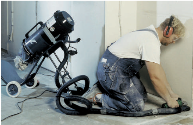
Fig. 14: Bearbeiding av overflate m/påmontert sug
