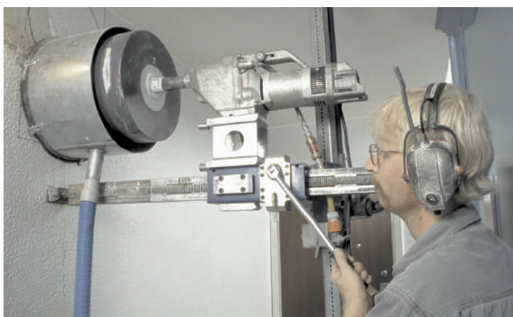
Fig 38: Avsug ved hullboring (kjerneboring)
