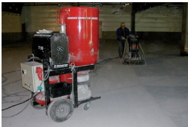
Fig. 13: Gulvsliping i kombinasjon med semimobil støvsuger
