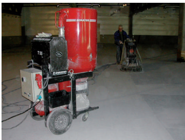
Fig 37: Semimobil støvsuger for større slipearbeider
