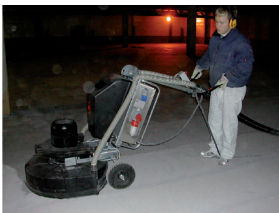
Fig 36: Gulvsliping der støvet fjernes ved kilden
