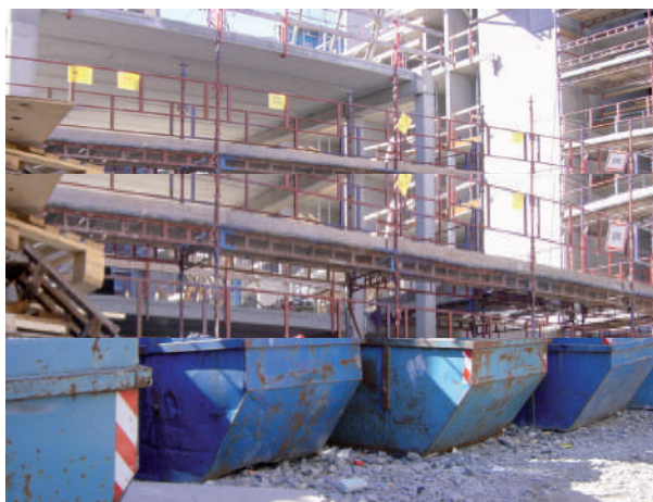
Fig 35: Kildesortering med containere nært bygget
