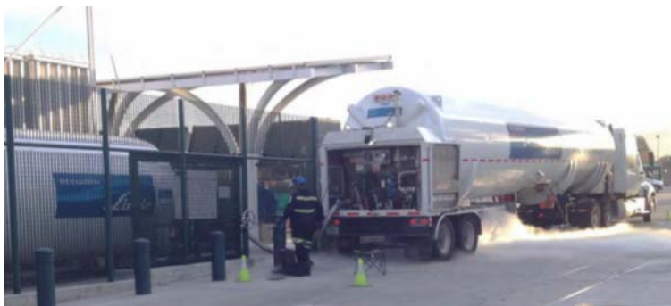
Figur 3.49 Fylling av flytende hydrogen på tankbil (Linde)
