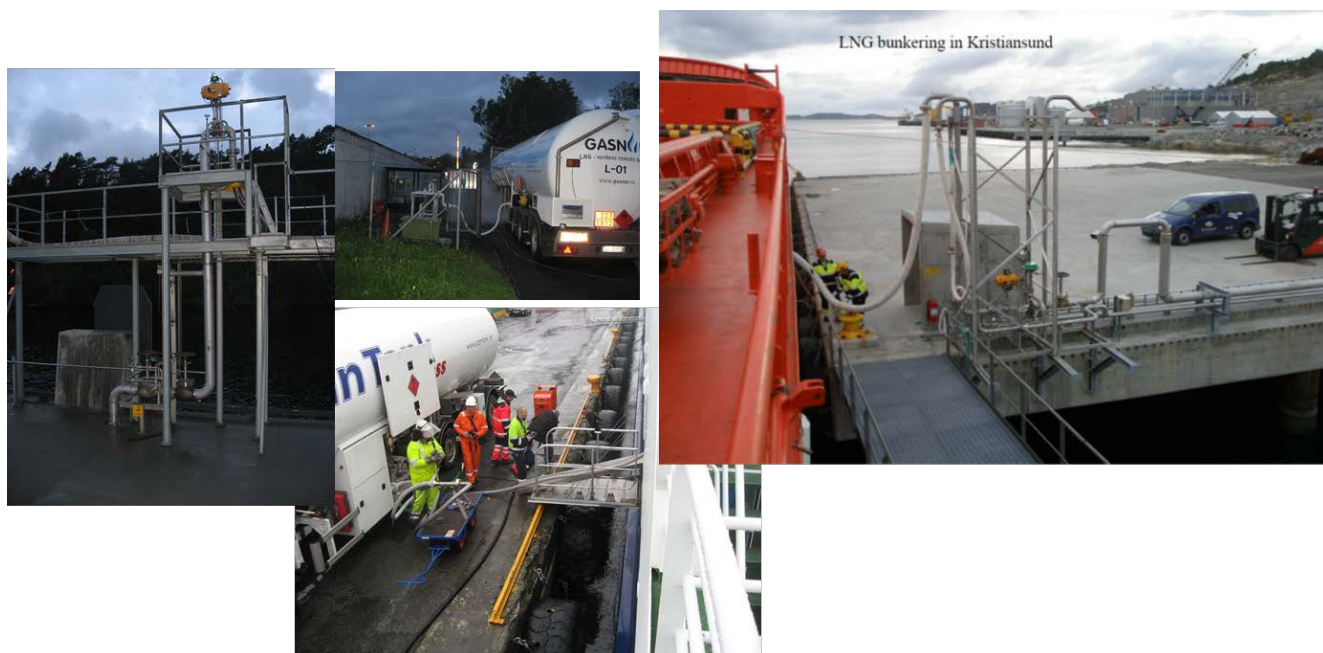
Figur 3.35 Eksempel på LNG bunkringssystemer, fast bunkringssystem for skip og bunkring fra tankbil
