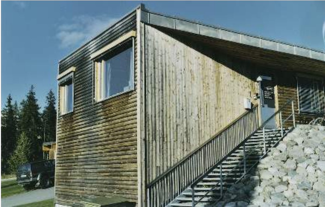
Figur 2.3.5-2 Eksempel på spill i fasade. Varierende retning på kledningsbord, samt takutstikk som gir variasjon i gråningen av kledningsbordene.
