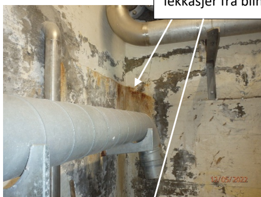
1.1 Injisering og drenering av lekkasjer fra blindkjellere og fjell
