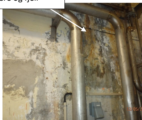
1.1 Injisering og drenering av lekkasjer fra blindkjellere og fjell
