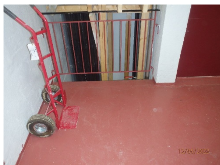
7.3 Montere sparkelist på rekkverk trapperepo
