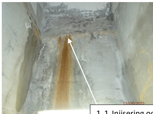
1.1 Injisering og drenering av lekkasjer fra blindkjellere og fjell
