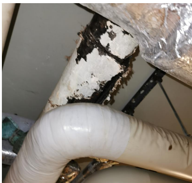
Bilde B11: Prøve nr. 11, rørisolasjon (ink. kork), klorrom
