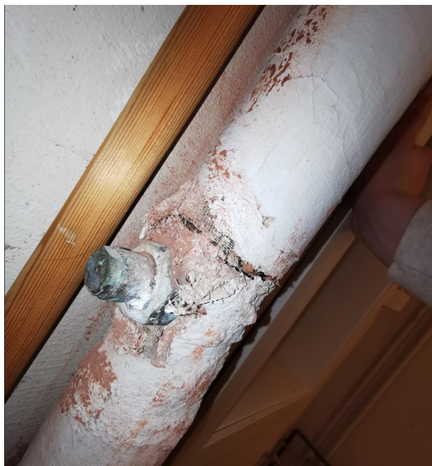
Bilde B9: Prøve nr. 9, rørisolasjon vaskerom
