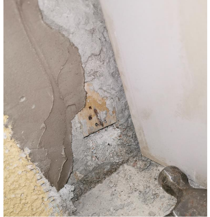
Bilde B6: Prøve nr. 6, betong midtvegg, bassengrom
