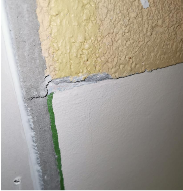
Bilde B5: Prøve nr. 5, ruglete veggpuss og maling, bassengrom
