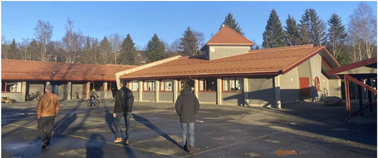
Foto mot gul fløy med teknisk rom stikkende opp av takflaten
