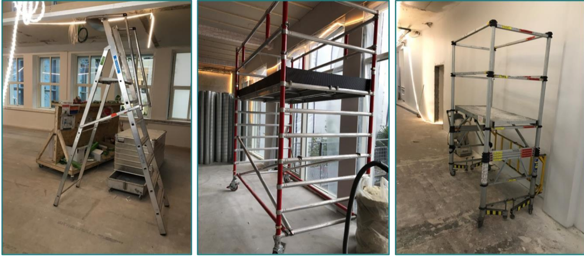
Figur 2 Eksempler på gode arbeidsplattformer, f.v.: Plattformstige, rullestillas, og rullestillas med teleskopfunksjon. Kilde/foto: Statsbygg
