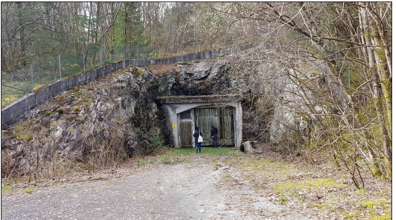
Figur 3-6: Tunnelportal for adkomsttunnel/betjeningstunnel i front av anlegget.
