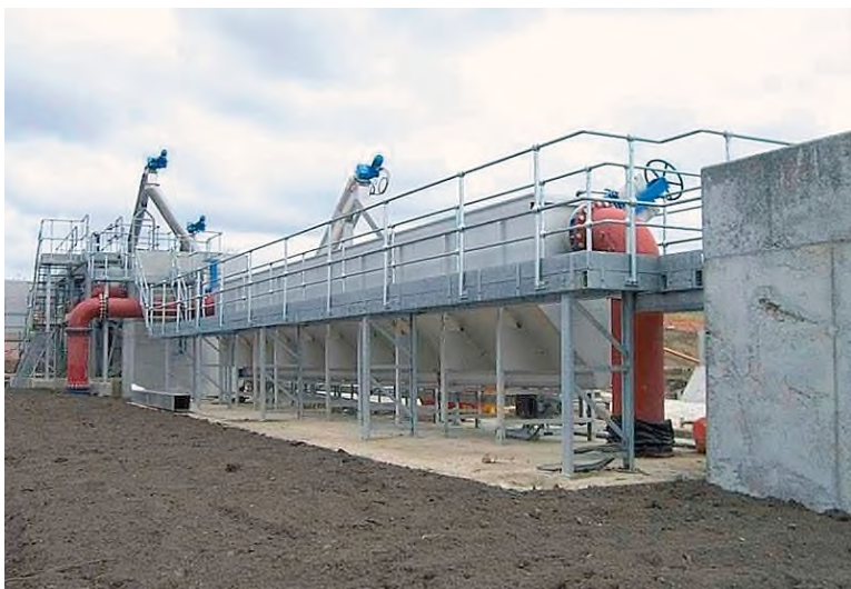
Figur 3.6: Bilde av aktuelt prefabrikkert sandfang, kilde: Huber
