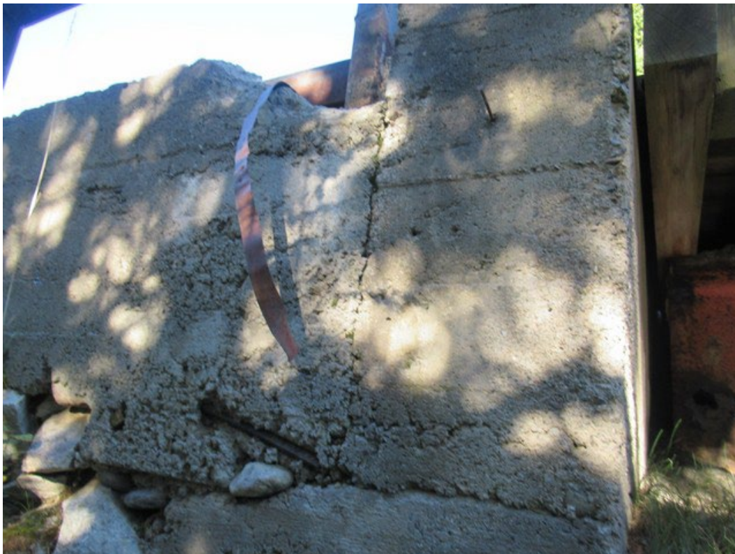
Bilde 4: Landkar – bakvegg og terskel i betong
