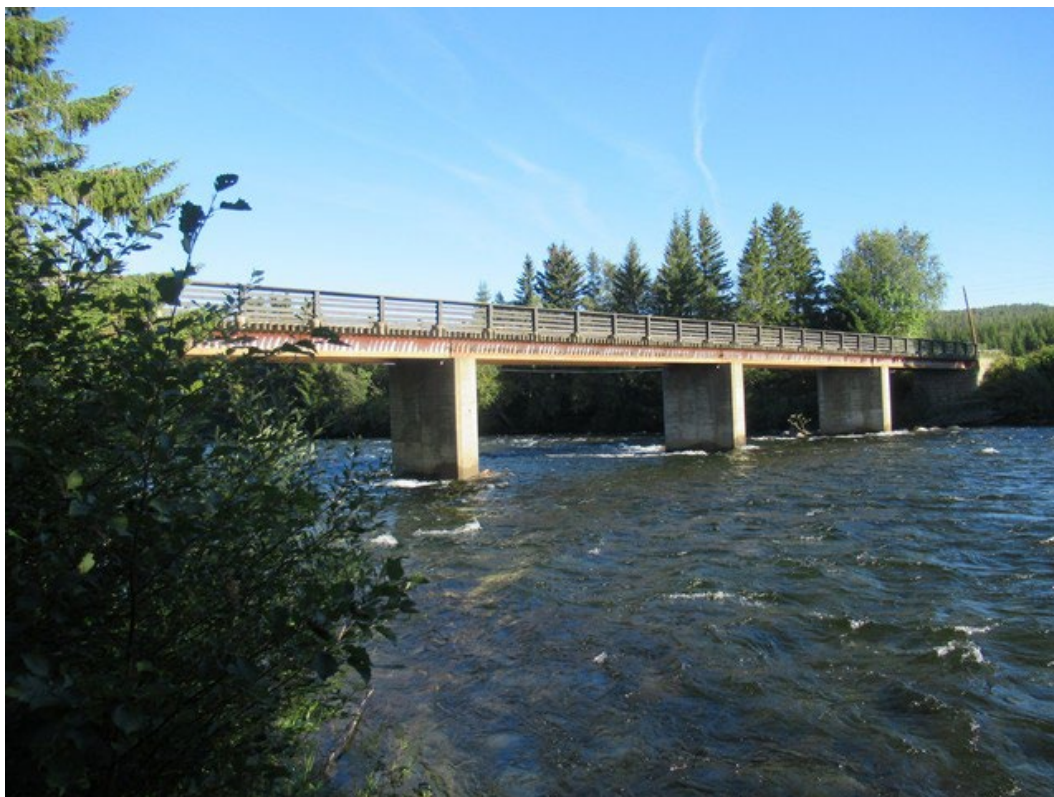
Bilde 1: Oversiktsbilde sett fra oppstrøms
