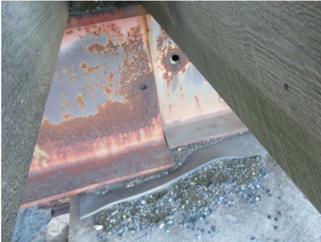
Bilde 7: Hovedbjelker, Opplegg på pilar
