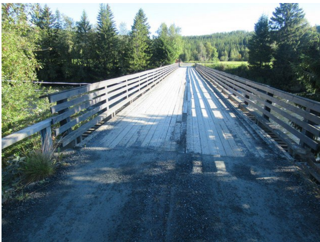
Bilde 2: Oversiktsbilde sett over brua
