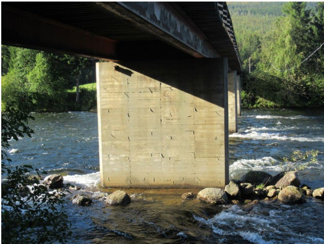
Bilde 6: Pilarer - Betong
