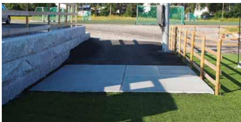
Betongkum med ramme og rist. Kum kan kjøpes ferdig eller støpes selv. Kummen har sluk med granulaterfilter i bunn. Foto: NFF/Tangmoen IL.
