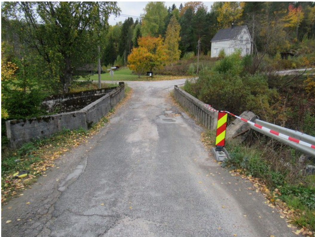
Bilde 2: Oversiktsbilde sett over brua
