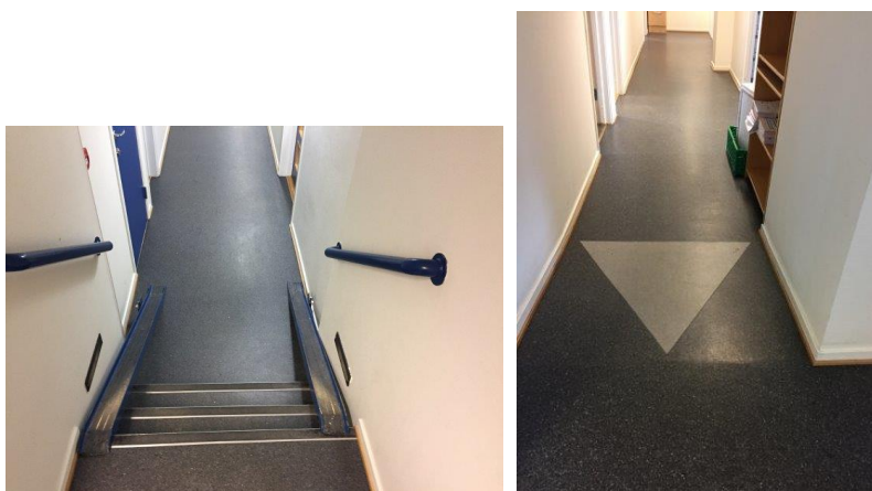
Foto viser trapp og rampe mellom nivåforskjeller i 2. etasje.
