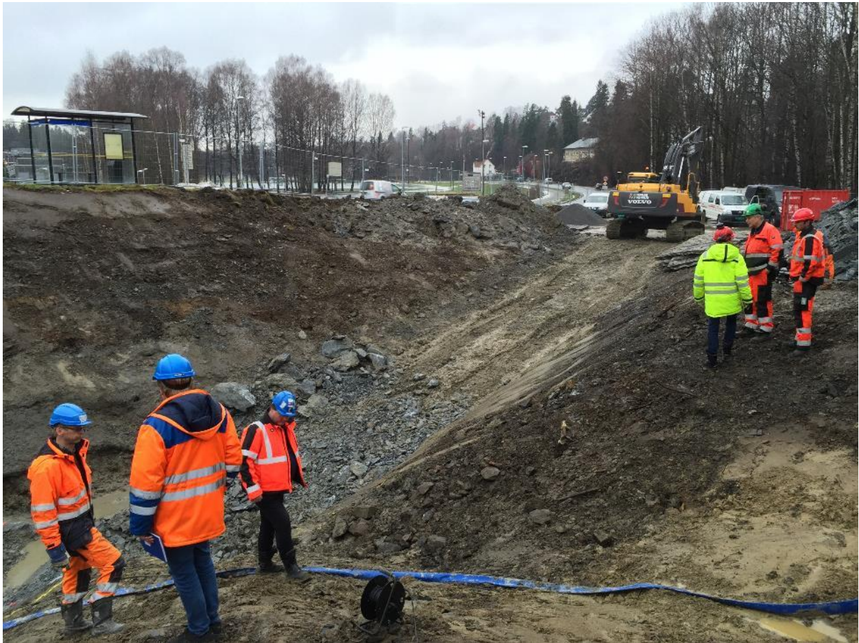
Figur 11: Foto fra Bærum kommune fra anleggsarbeidene inne på riggplassen i forbindelse med etablering av kassetmagasin.
