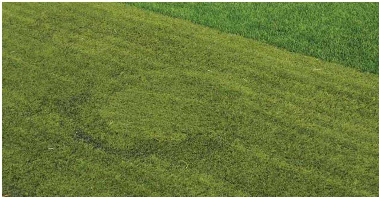
Overvannet filtreres gjennom sandinnfyllet i kunstgresset før det går til avløp. Moan stadion, Levanger Foto: NFF.
