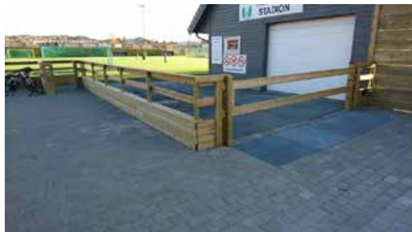
Kjøreport med kjøresterk rist for rengjøring av vedlikeholdsmaskin. Tangmoen, Stjørdaal. Foto: Tangmoen IL.
