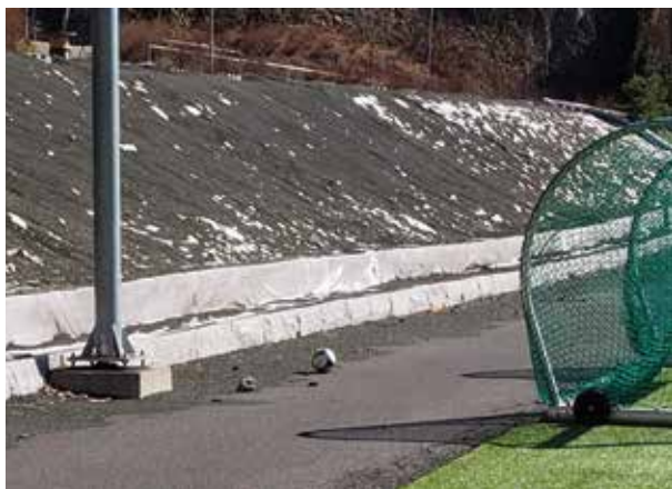
Fiberduk lagt i tillegg gressareal for oppsamling av snø med granulat. Foto: NFF.
