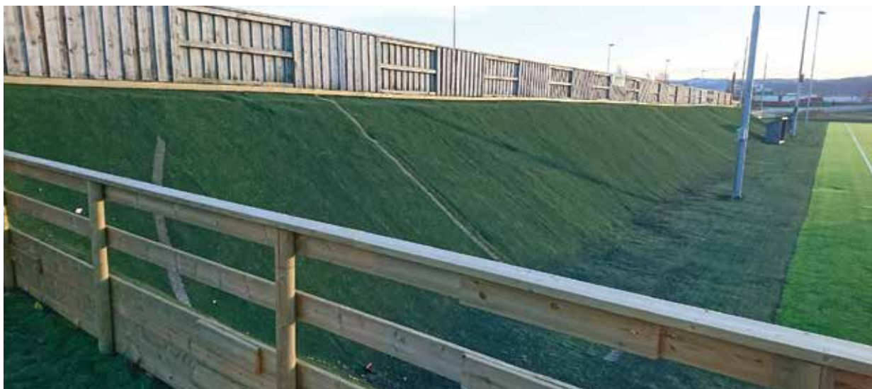
Snødeponi med gjenbrukt kunstgress fra den rehabiliterte banen. Lagt på dugnad av klubb. Tangmoen IL, Stjørdal. Foto: Tangmoen IL.
