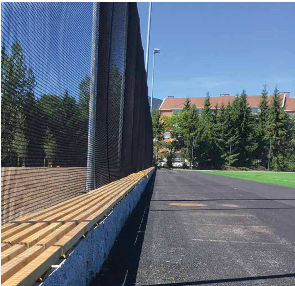
Drensasfalt med fall inn mot kunstgressbanen og tette kumlokk. Banen har ingen åpne sluk. Kalbakken 2, Oslo. Foto: Bymiljøetaten Oslo.
