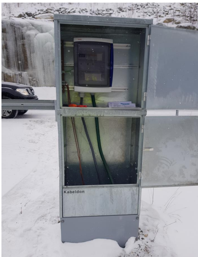
Figur 2.1: Eksisterende fordelingskap ved Rondablikkvegen.
