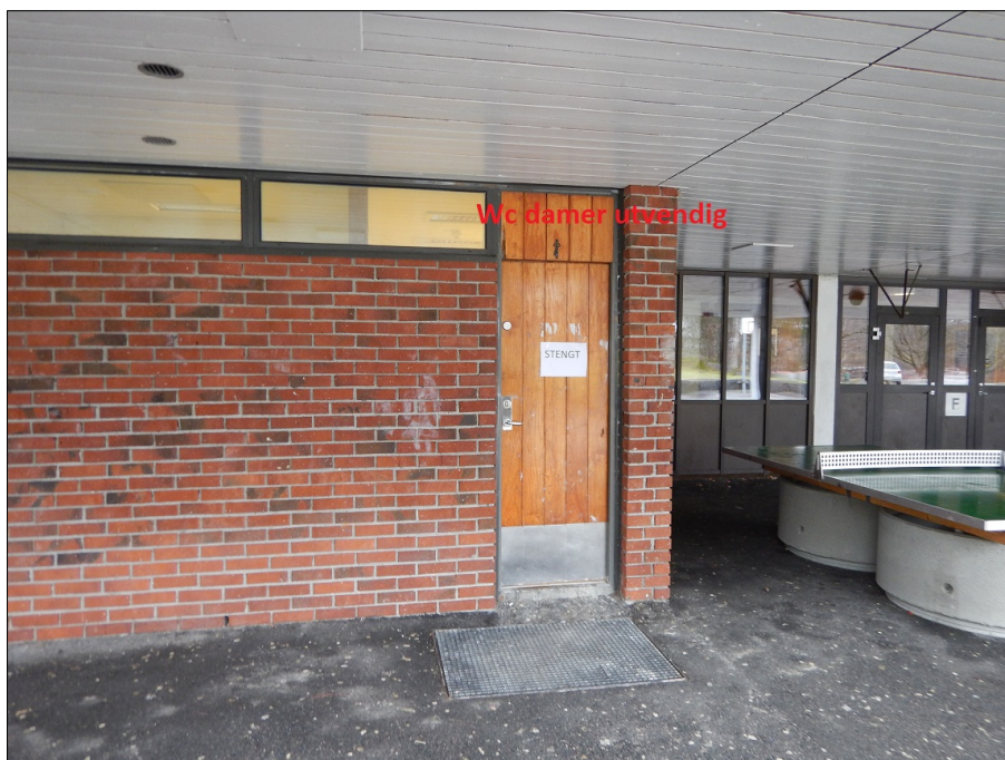
Foto: Oversikt wc damer utvendig.JPG Om, Start inspeksjon -
