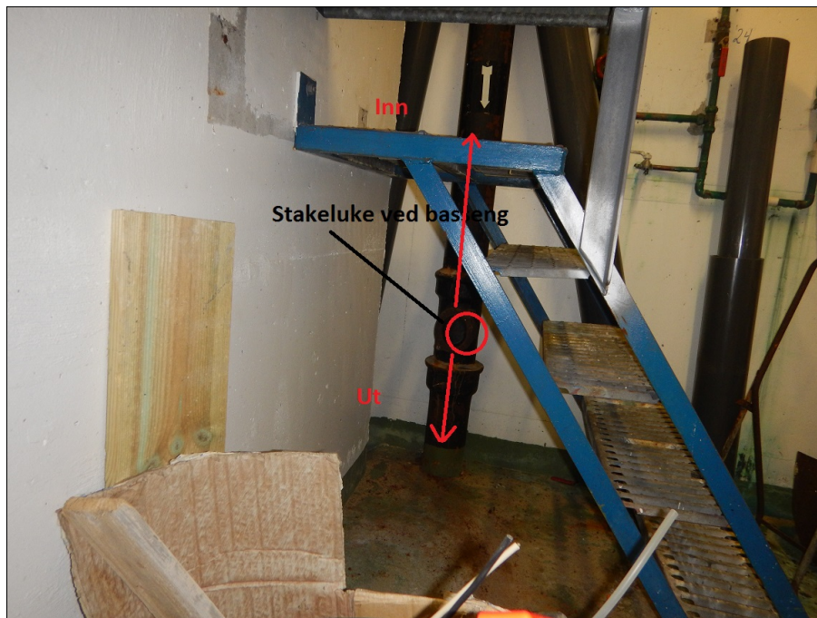
Foto: Stakeluke ved basseng.JPG Om, Start inspeksjon -
