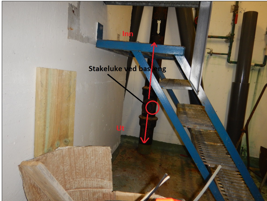
Foto: Stakeluke ved basseng.JPG Om, Start inspeksjon -
