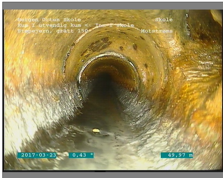
Foto: 1_SI_WorkNumber_S_Sectionname_Inn i skoleKum 1 utvendig kum23032017122554_A.JPG 50,82m, Inspeksjon avbrutt Andre, trolig mindre dimensjon
