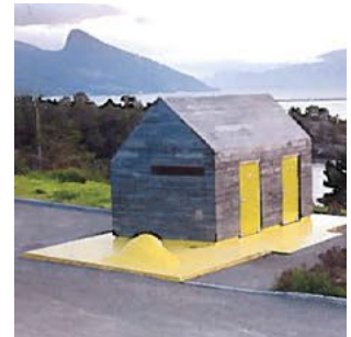
Toalettbygg Hereiane 3RW Arkitekter | Møte mellom bygg og landskap, den gule betongen løper kontinuerlig gjennom hele bygget og danner uteplass, sitteelement, indre gulv og skillevegg mellom de to toalettene.
