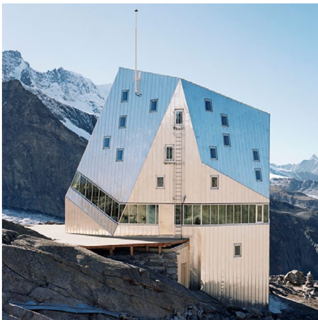
Monte rosa hut, Andrea Deplazes | Fasaden tar opp i seg farger fra omgivelsene
