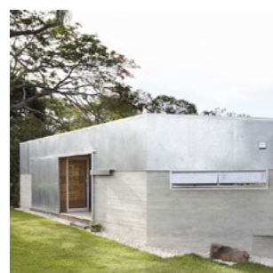
Keperra house, A-CH | Overgang mellom metall, betong og tre
