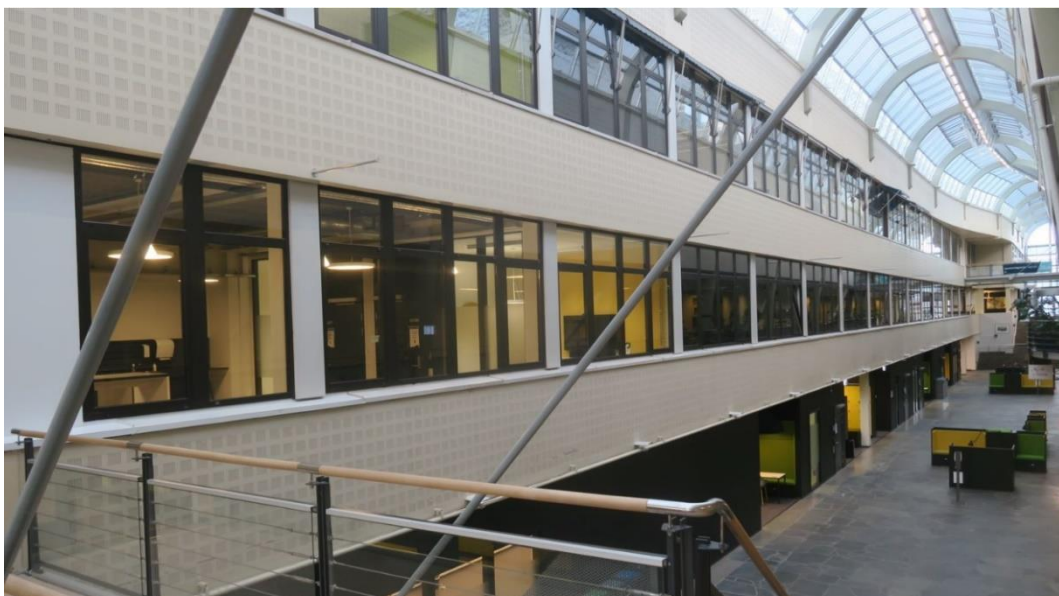
Bilde 4 viser fasaden på teorifløya. Feltene under, imellom og over vindusrekkene er akustikkplater som skjuler internitplater
