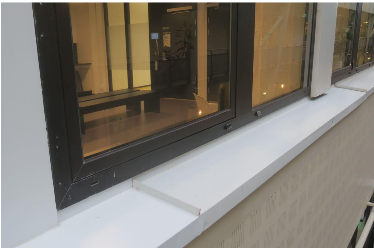
Detaljbilde av utside vindu.
