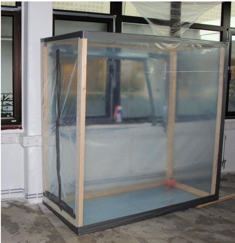
Figur 6: Sluse som ble benyttet for å fjerne gerikter.
