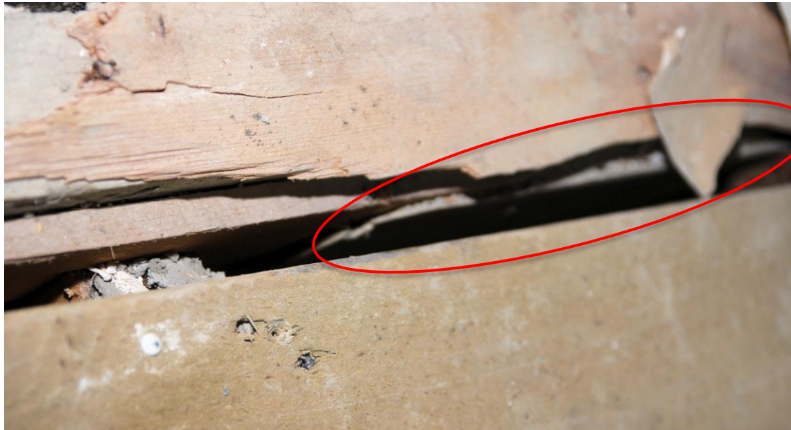
Figur 12: Knust Internit-plate i veggen.
