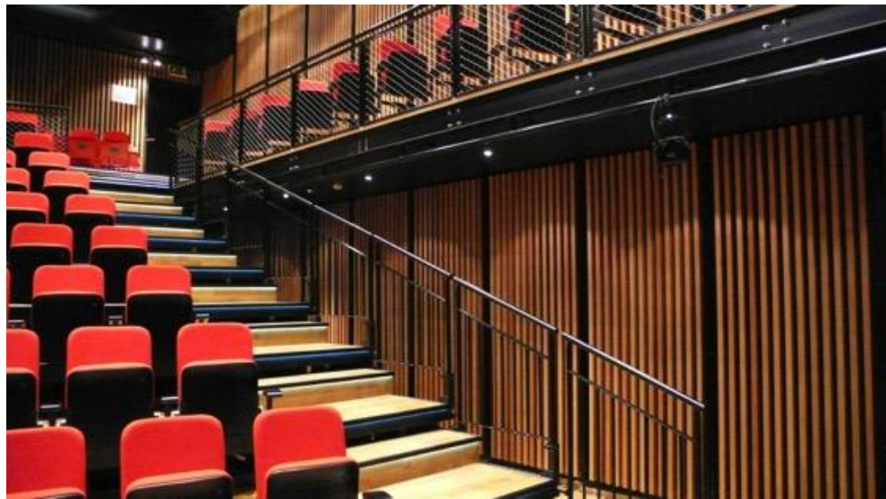
Plassen kulturhus, Teatret Vårt, Molde 2013. Loddrette eikelister i feltene mellom Unistrut-profilene. En slik spilevegg er ikke akustisk åpen nok til at høyttalere kan plasseres skjult i vegg.
