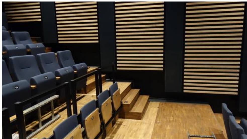
Fosnavåg konserthus 2014. De mørke feltene er dekket med høyttalerfrontplater i perforert stål for å være åpne nok for lyden. Fast amfi og teleskopamfi med gulv og trapper med smålamellparkett.
