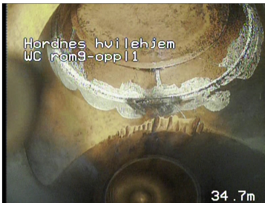
Foto: 001755__oppløp1_Wc 1etg rom 1_2105202121052021.jpg 34,7m, Tilkopling Andre, 12 Kl., Stakeluke u-etg, oppløp 1
