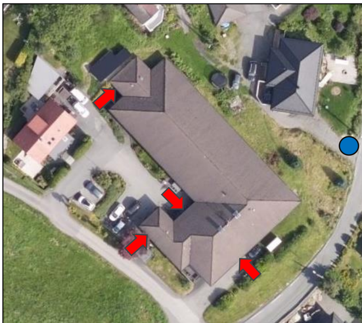
Figur 2: Situasjonsbilde av Hordnestunet sykehjem. Mulige innsatsveier for brannvesenet er angitt med røde piler. Nærmeste slokkevannsuttak er merket med blå sirkel.
