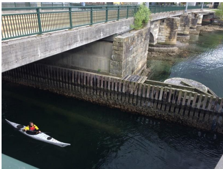
Figur 7 Farbart løp under Gamle Nygårdsbro i forgrunnen samt 5 ikke-farbare løp.
