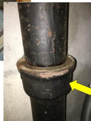
Figur 2. Gammelt avløpsrør av støpejern. Pilen viser plassering av eventuell asbestholdig tettemasse. Det er kun denne typen støpejernsrør vi kjenner til at det kan være brukt asbest i. Det er imidlertid ikke uvanlig at rørene er malt utenpå.
