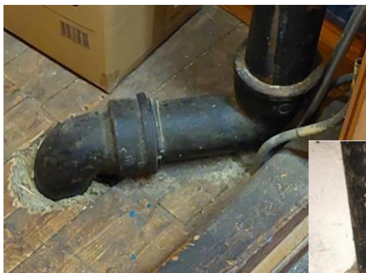
Figur 2. Gammelt avløpsrør av støpejern. Pilen viser plassering av eventuell asbestholdig tettemasse. Det er kun denne typen støpejernsrør vi kjenner til at det kan være brukt asbest i. Det er imidlertid ikke uvanlig at rørene er malt utenpå.
