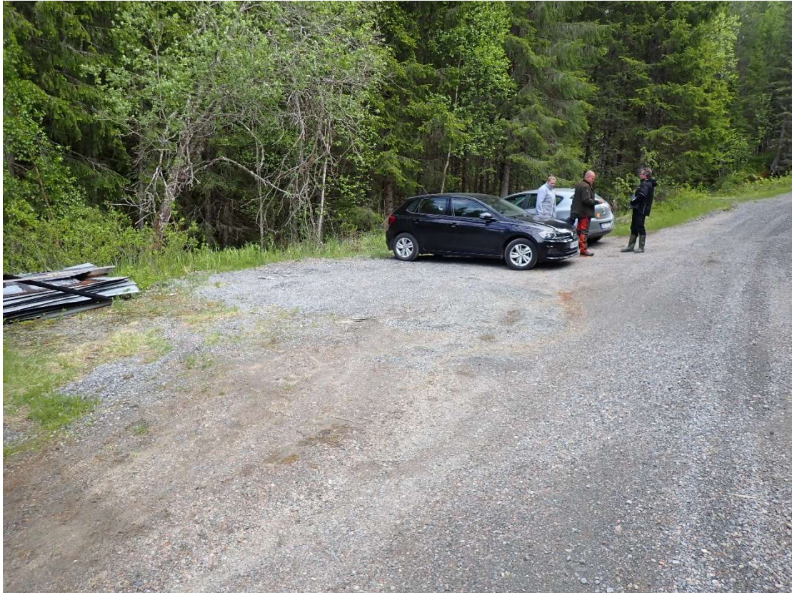
Figur 1. Ved start adkomstvei 1. Området vil brukes til mellomlagring av masser for vei.
