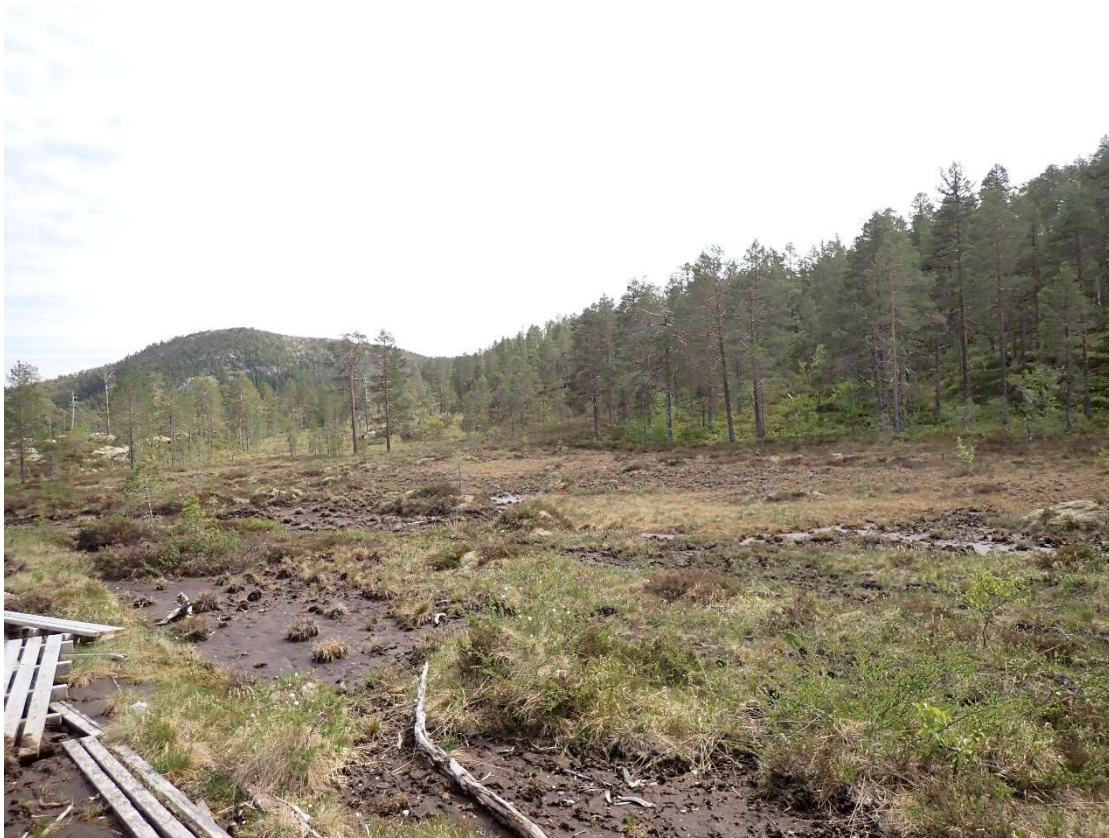
Figur 18. Adkomstvei 1 – kryssing av myr.
