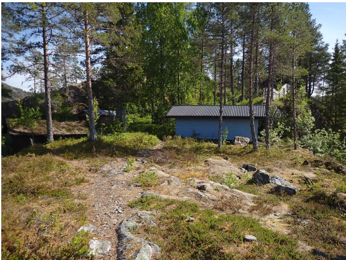
Figur 42. Adkomstvei 2 – Bygg må sannsynligvis rives eller rives.
