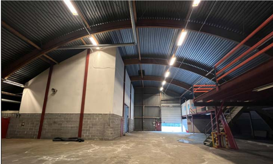
Figur 5: Innvendig i lagerhallen. Mesaninen sees som rød konstruksjon til høyre i bildet. Verkstedet ligger bak de hvite veggene. Foto er tatt mot nordøst. Foto: Multiconsult.
