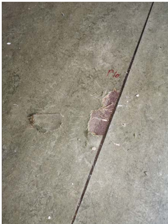
Figur 11: Linoleumsbelegg på gulv i andre etasje i kontordel. Det ble ikke påvist asbest i gulvbelegget.
