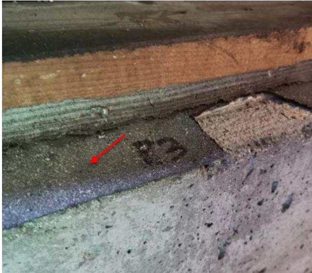
Figur 16: Takpapp mellom grunnmur og trekonstruksjon i vegger.
