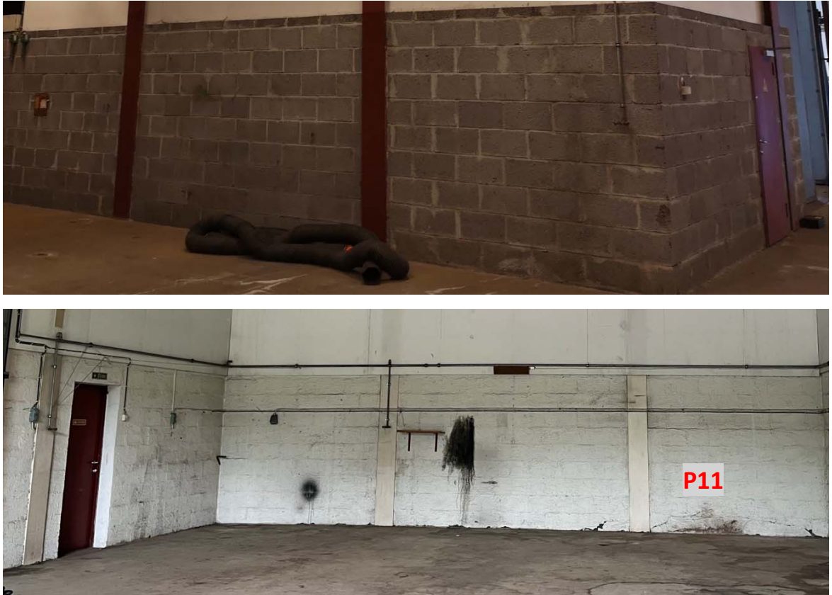
Figur 28: Bilde av umalte og malte Lecavegger i verkstedet. Prøve P11 ble tatt av hvit maling på Leca-vegger.
