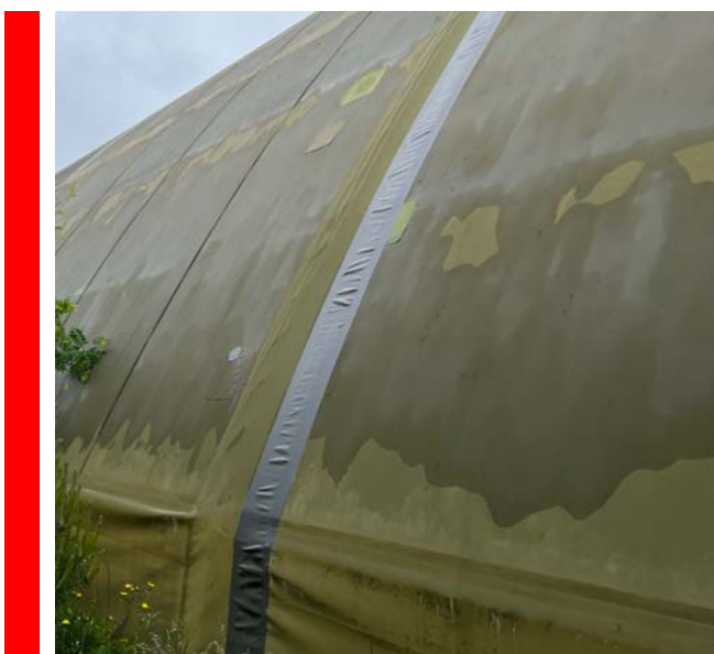
Figur 15: Takduk på lagerhall. Duken inneholder ftalater over grensen for farlig avfall.
