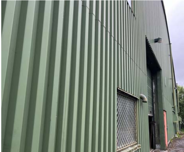
Figur 20: Grønnmalte stålplater på fasader på lagerhall.
