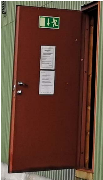
Figur 12: Branndør fra 1985. Døren inneholder ikke asbest.
