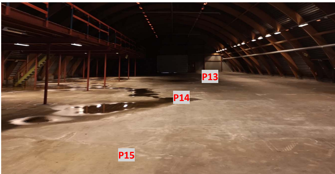
Figur 27: Bilde av betongdekket i lagerhallen. Prøve P13–P15 ble tatt fra ulike deler av betongdekket.
