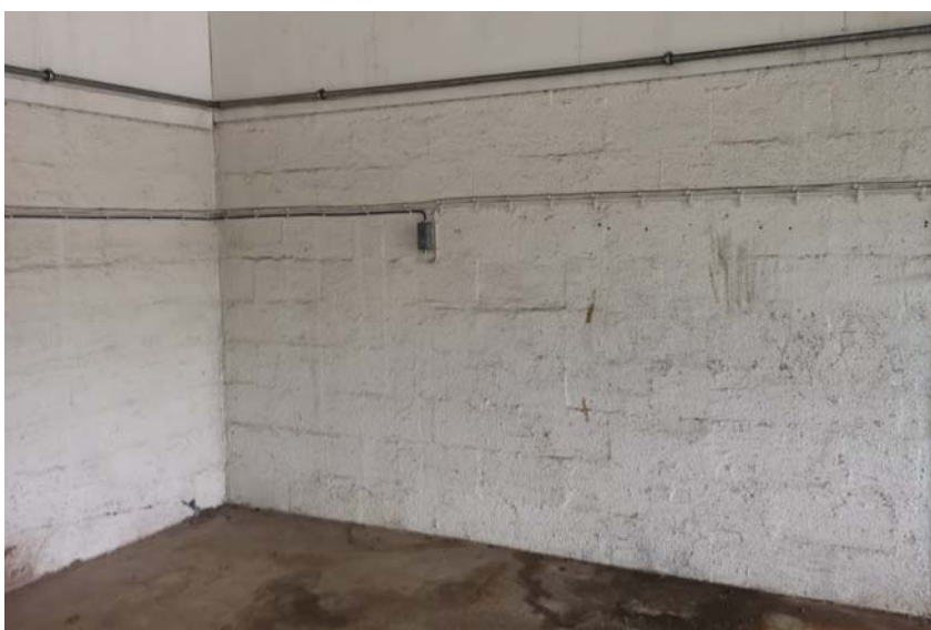
Figur 21: Hvit maling på Leca-vegg i verksted. Prøve P11 ble tatt av malingen. Det ble ikke påvist PCB eller tungmetaller over grensen for farlig avfall i malingen.
