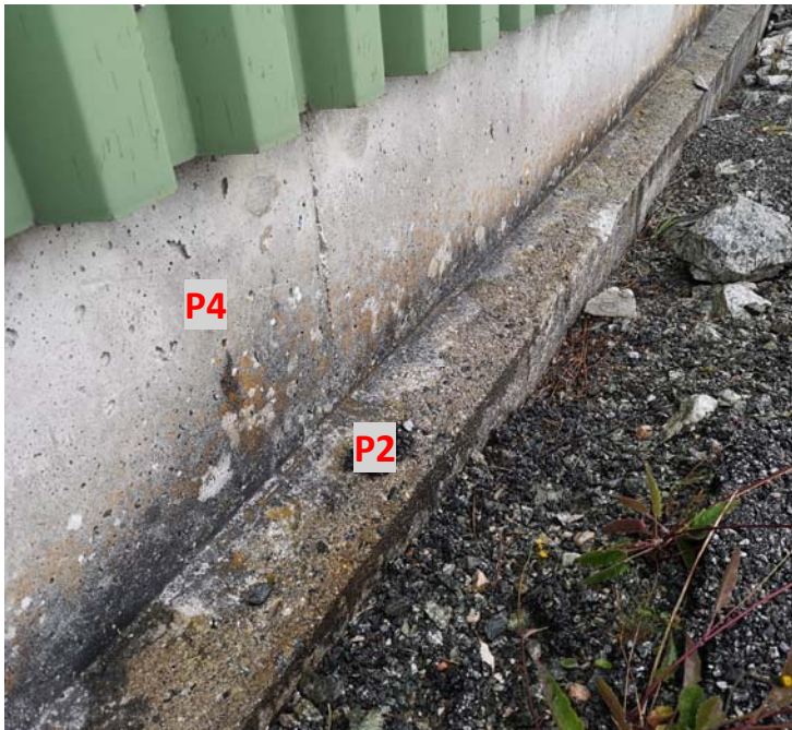
Figur 26: Bilde av fundamentet til grunnmuren, og grunnmuren. Prøve P2 og P4 ble tatt av betongkonstruksjonene.
