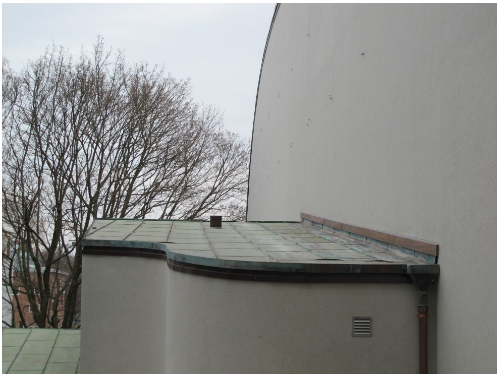
Lavt tak på siden mot nordøst.
