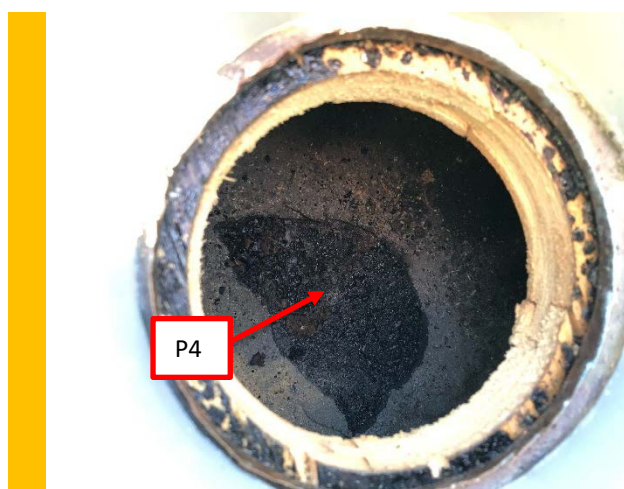
Figur 7 Korkisolasjon (P4) under takpapp på tak over Store studio. Prøven inneholdt ikke asbest.
