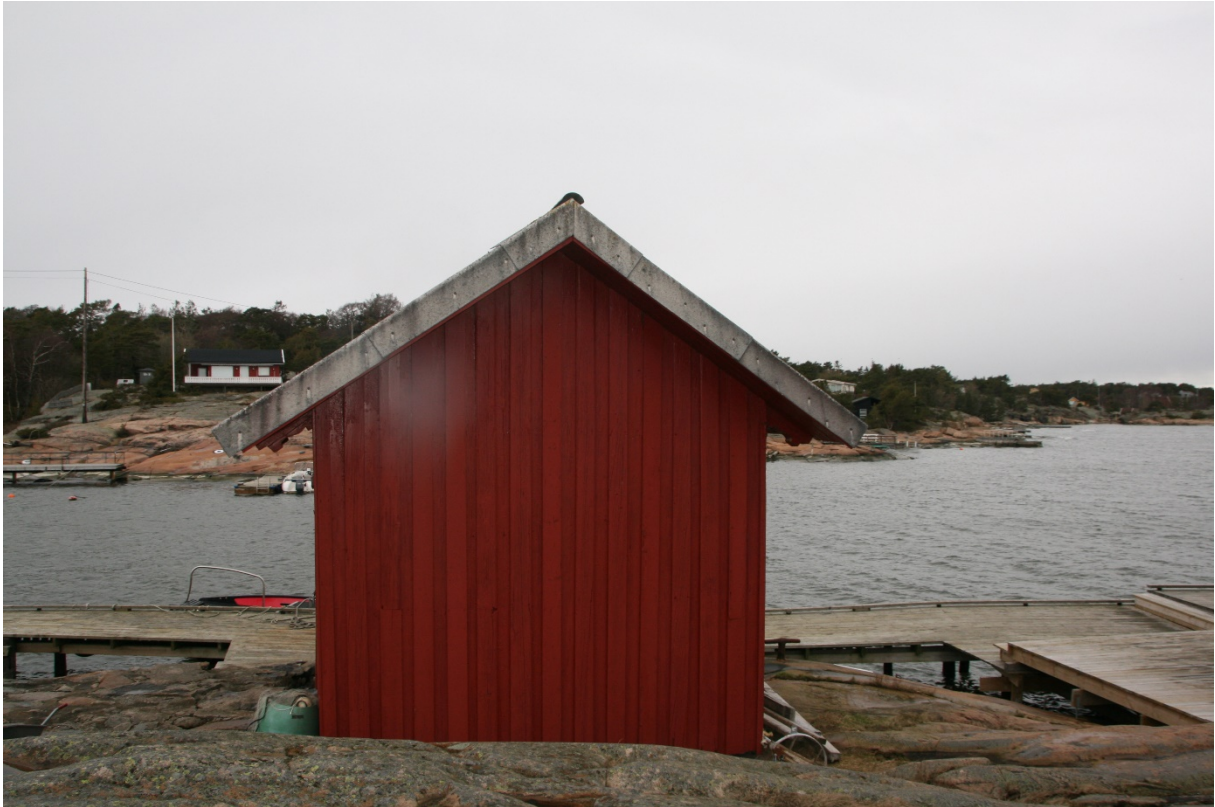
Naust fasade mot sydøst.
