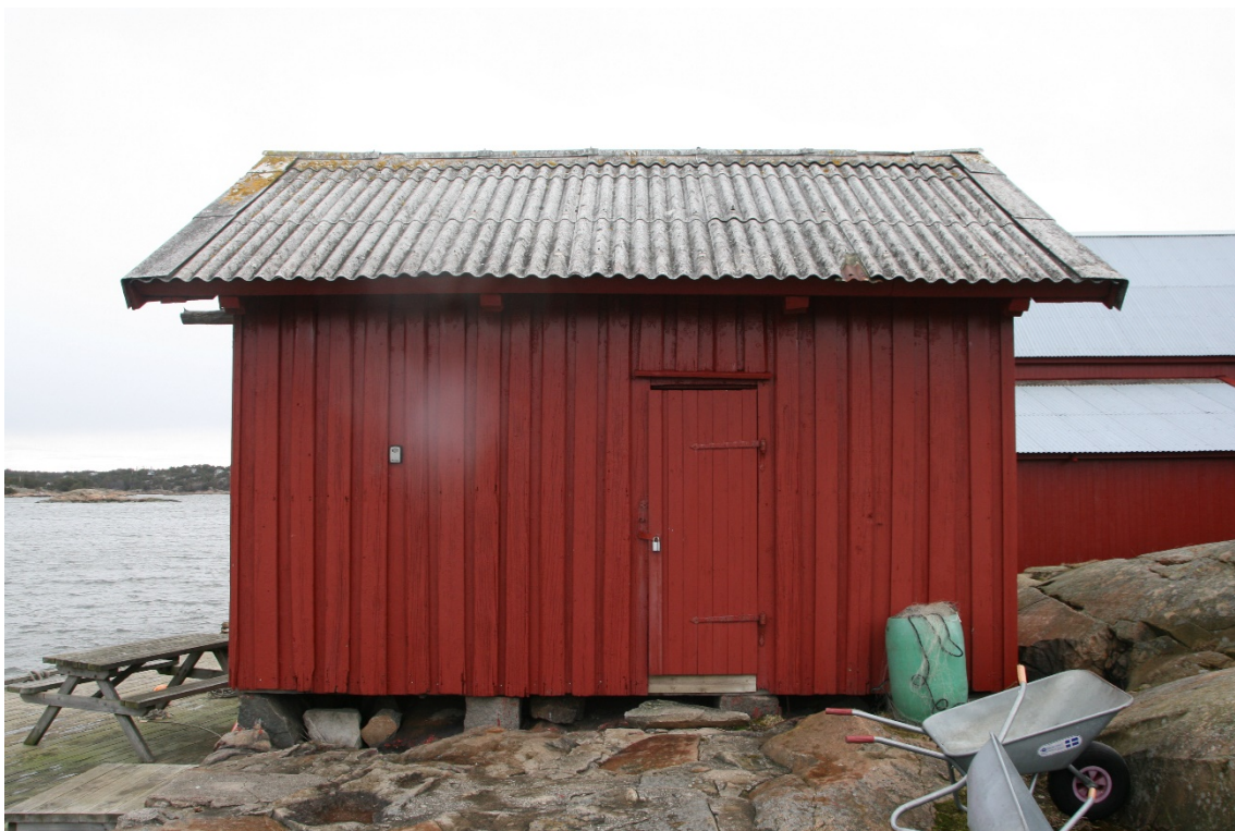
Naust fasade mot sydvest. Taket er kledd med eternitt bølgeplater.
