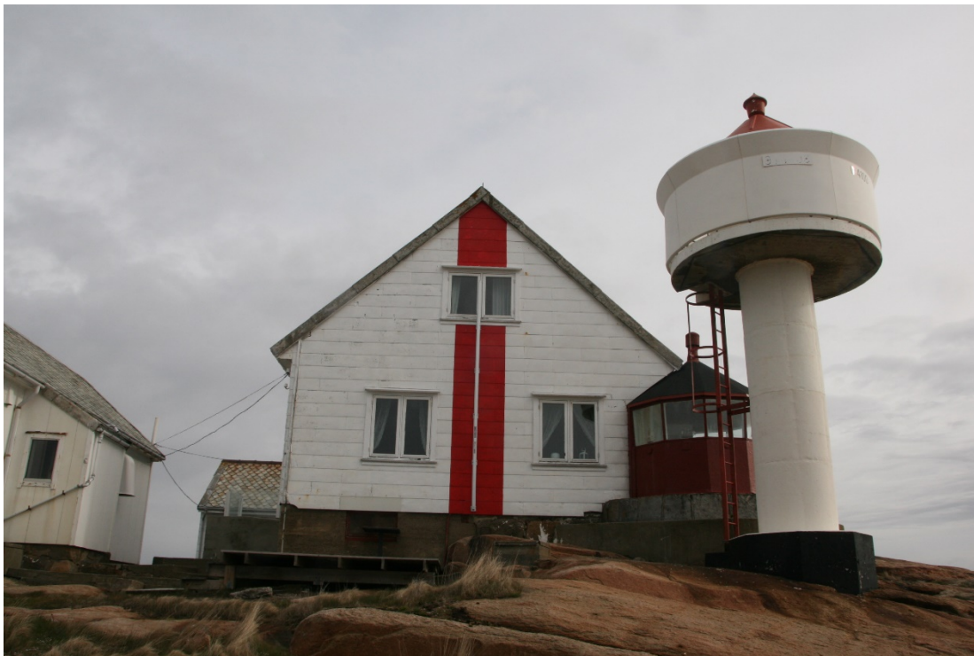
Fyrbolig fasade mot syd.
