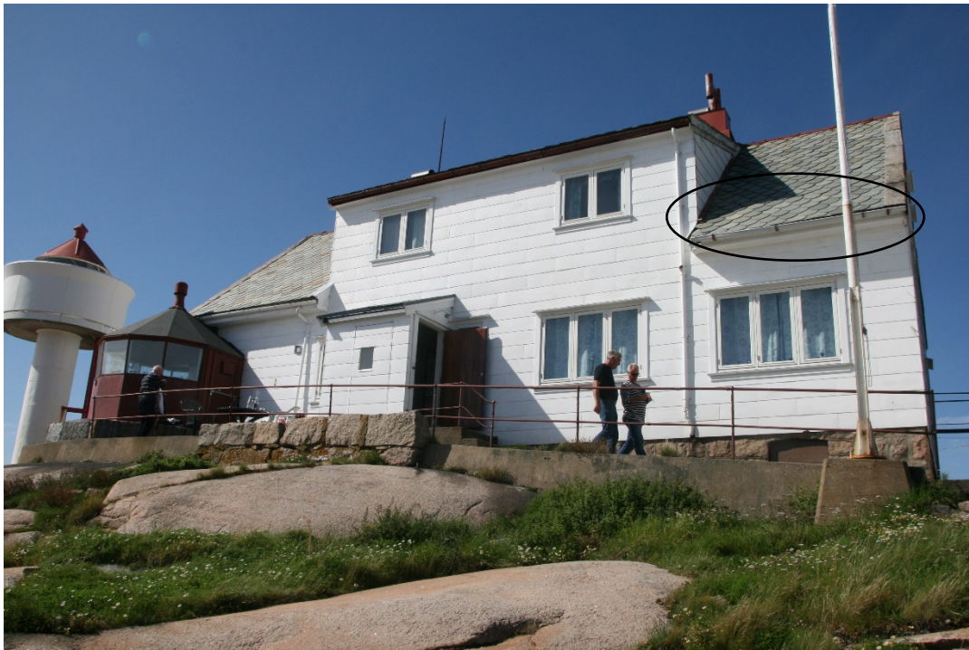
Fyrbolig fasade mot øst.
