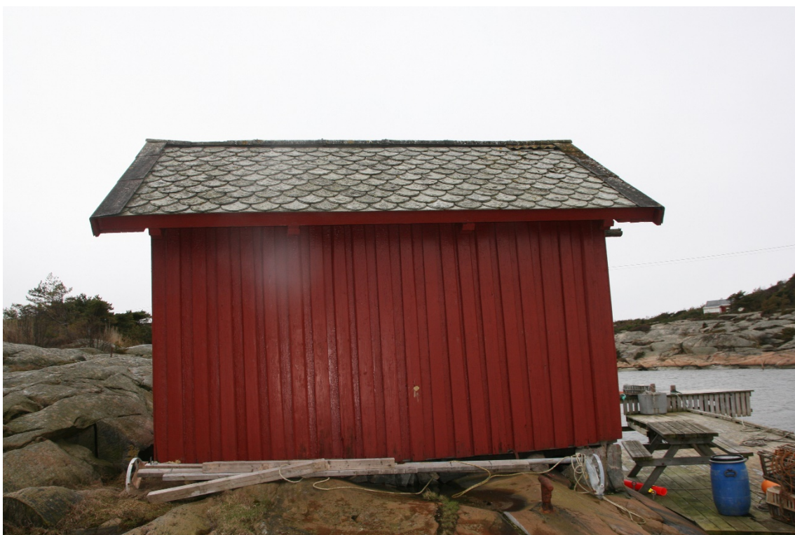
Naust fasade mot nordøst. Taket er kledd med skifer takstein.
