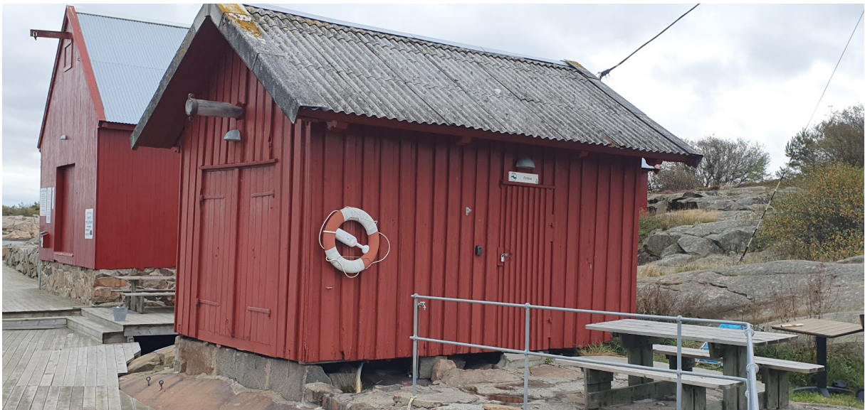
Naust fasade mot vest.
