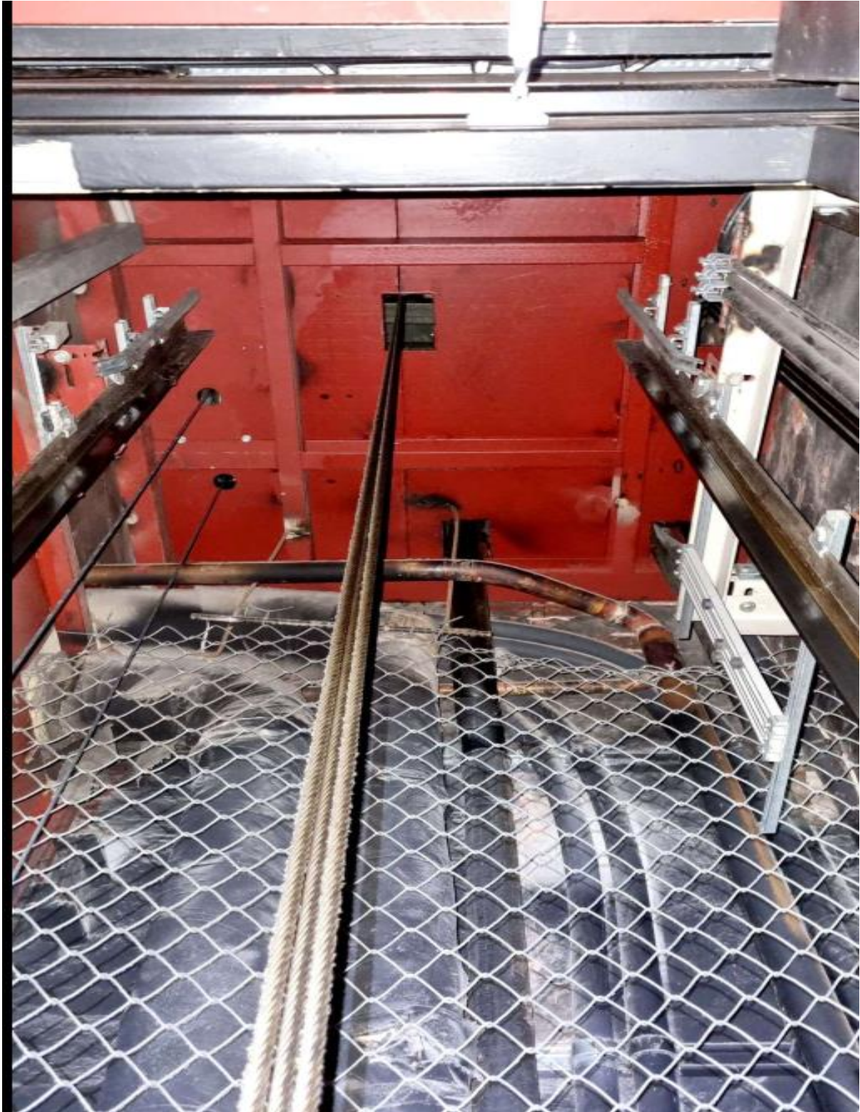
Figur 5 Sjakt topp – maskinrom underside, stål topp
