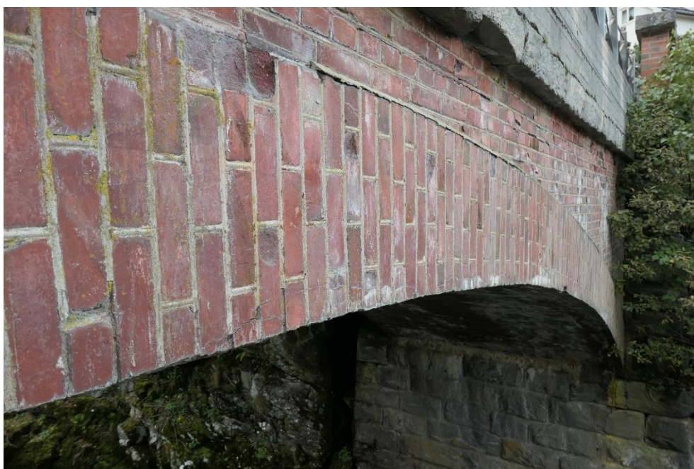
Figur 3 Loddrett sidevegg nedstrøms står på buet hvelv
