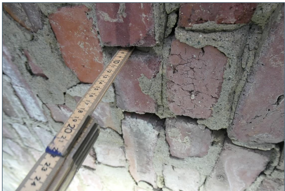
Figur 14 Hvelv underside. Tomme fuger fylles med mørtel.
