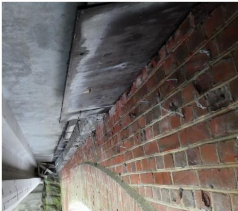
Figur 16 Sidevegg oppstrøms med gjenglemt forskalingsbord
