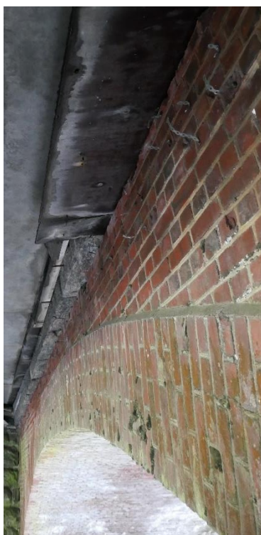
Figur 6 Loddrett sidevegg oppstrøms står på buet hvelv.
