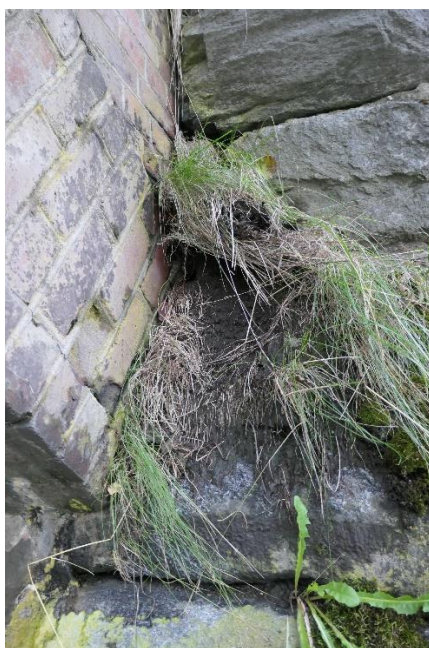
Figur 18 Mose og vegetasjon ved hvelvfot fjernes
