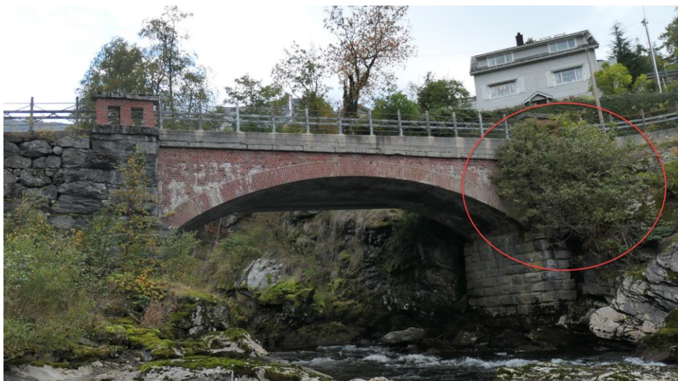
Figur 17 Fjerning av gress og begroing
