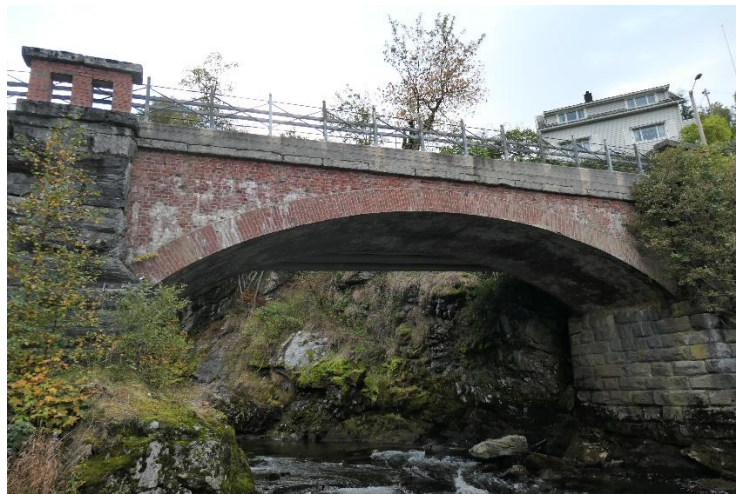
Figur 1 15-0148 Høgebrua - Hvelvbru sett fra nedstrøms side
