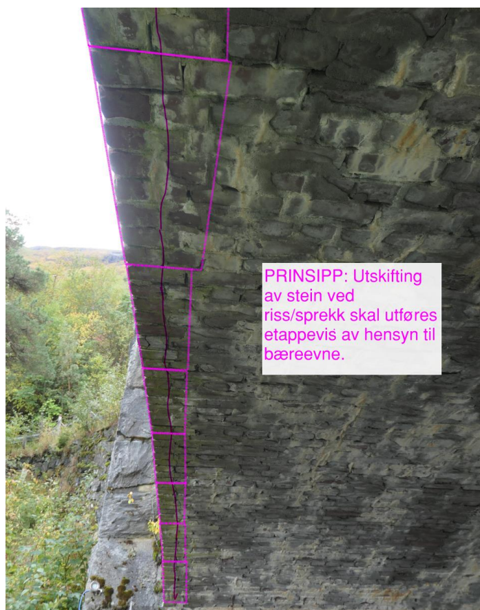
Figur 10 Loddrett sidevegg nedstrøms. Prinsipp for omfang. Stein markert med kryss i figur er skadet og skal skiftes.
