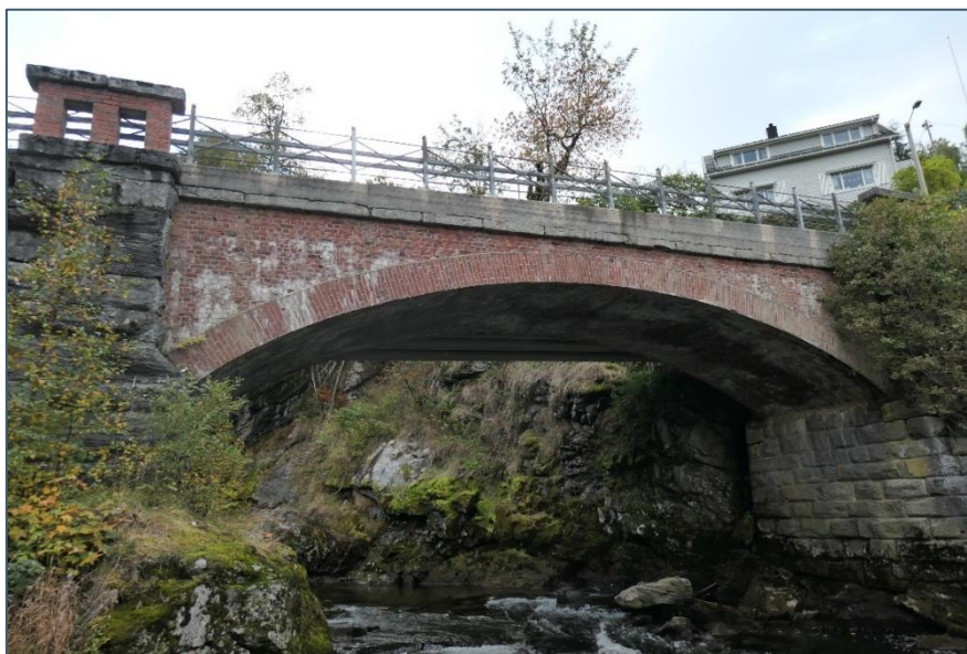
Figur 3 Loddrett sidevegg nedstrøms står på buet hvelv
