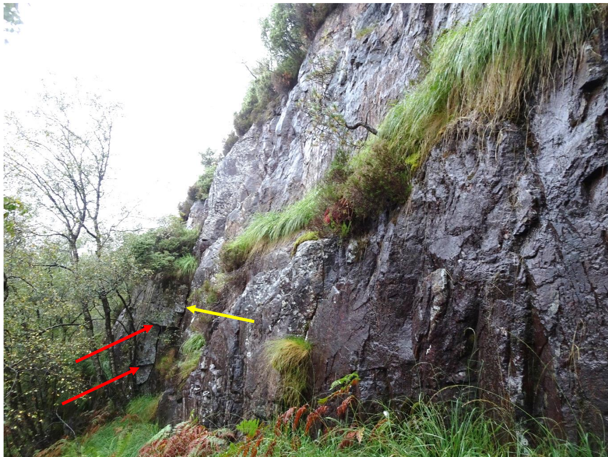
Figur 4. Bergskråning øst for demningen. Bildet er tatt mot nord ca. 200 moh. N-S-orientert sprekke med steilt fall mot vest er markert med gul pil. Røde piler peker på nær-horisontale sprekkesett med strøk mot N-S.
