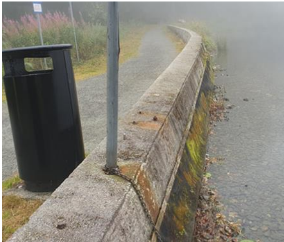
Figur 6 Svartatjørna. Foto av brystning og membran (svart duk mot vannet). Foto er tatt mot vest.
