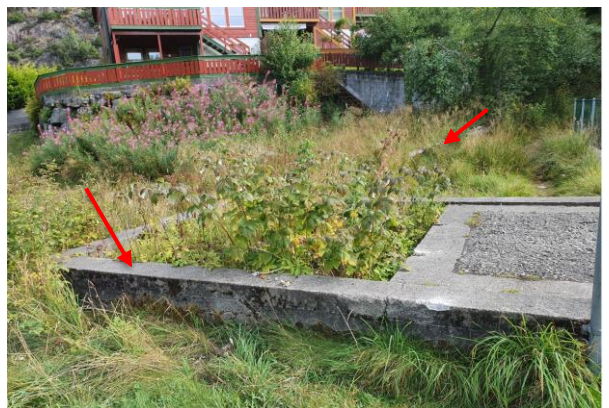
Figur 5 Storavatnet N. Foto av betongmurer like nord for dammen. Foto er tatt mot øst.
