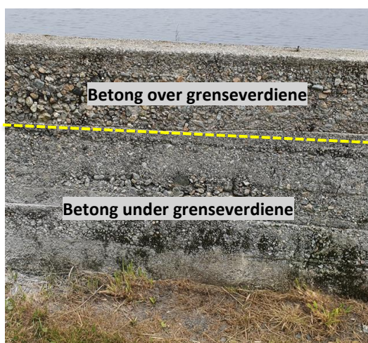
Figur 15 Svartatjørna. Foto av de ulike lagene med betong i demningen. I øverste ca. 1/3 del av demningen er det påvist konsentrasjoner av krom III og krom VI over grenseverdiene, mens det i nederste 2/3 del av demningen ikke er påvist konsentrasjoner over grenseverdiene.
