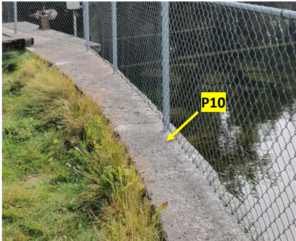
Figur 12 Storavatnet N. Prøve av betongkonstruksjonen over vannivå (P10).
