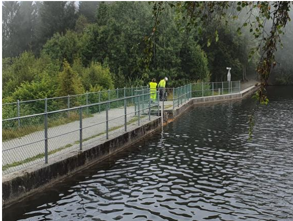
Figur 2 Dam Storavatnet. Overløpet skal rives for å etablere nytt flømløp. Foto er tatt mot nord.
