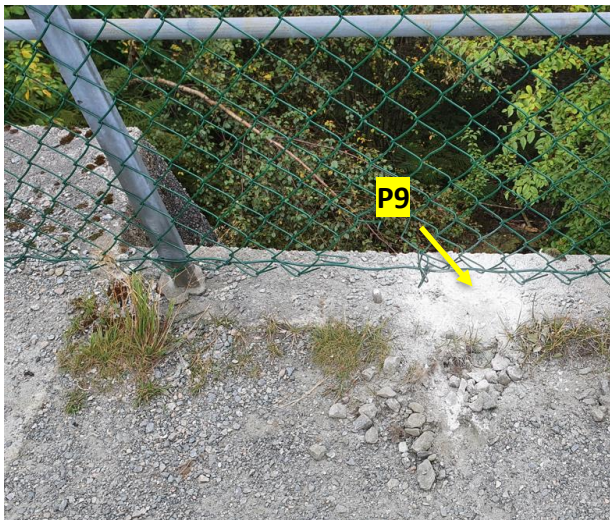
Figur 14 Dam Storavatnet. Prøve av betong like utenfor overløpet (P9).
