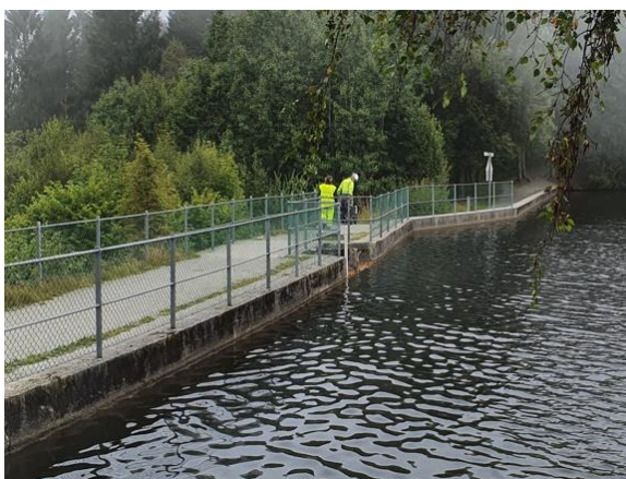
Figur 2 Dam Storavatnet. Overløpet skal rives for å etablere nytt flomløp. Foto er tatt mot nord.
