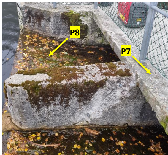
Figur 13 Dam Storavatnet. Prøve av betong fra dekket over overløpet (P7) og fra betongen i overløpet (P8).
