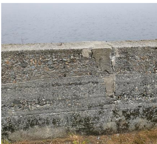
Figur 9 Svartatjørna. Foto av betongmuren på dammen. Foto er tatt mot nord.
