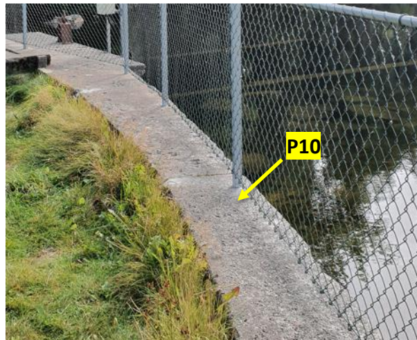
Figur 15 Storavatnet N. Prøve av betongkonstruksjonen over vannivå (P10).
