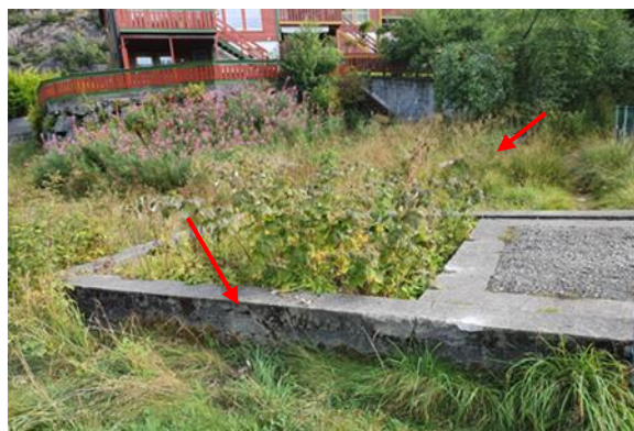
Figur 7 Storavatnet N. Foto av betongmurer like nord for dammen. Foto er tatt mot øst.
