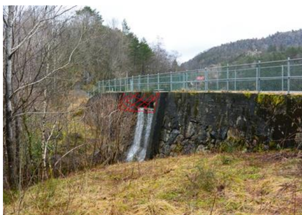
Figur 3 Dam Storavatnet. Betongkonstruksjonen som skal rives er vist med rødskravering. Foto er tatt mot nordøst.
