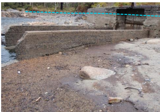
Figur 6 Storavatnet N. Bildet viser deler av dammen som vanligvis ligger under vannnivå. Bildet ble tatt da Storavatnet var nedtappet i 2012. Vannnivå da beferingen ble utført er markert med blåstiplet linje. Foto tatt mot nordvest.
