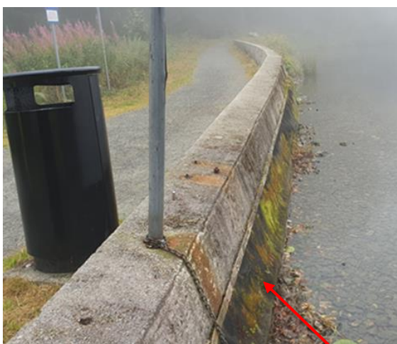
Figur 8 Svartatjørna. Foto av brystning, og membran (svart duk mot vannet). Foto er tatt mot vest.
