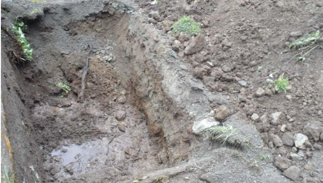
Bilde 4: Bildet viser grunnforholdene i sjakt 2 ved Løvstakkvatnet Sør.
