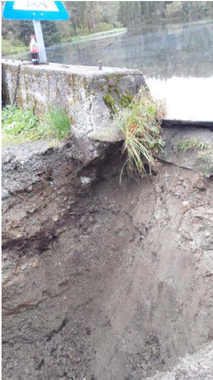
Bilde 6: Bildet viser grunnforholdene i sjakt 4 ved Løvstakkvatnet Sør.
