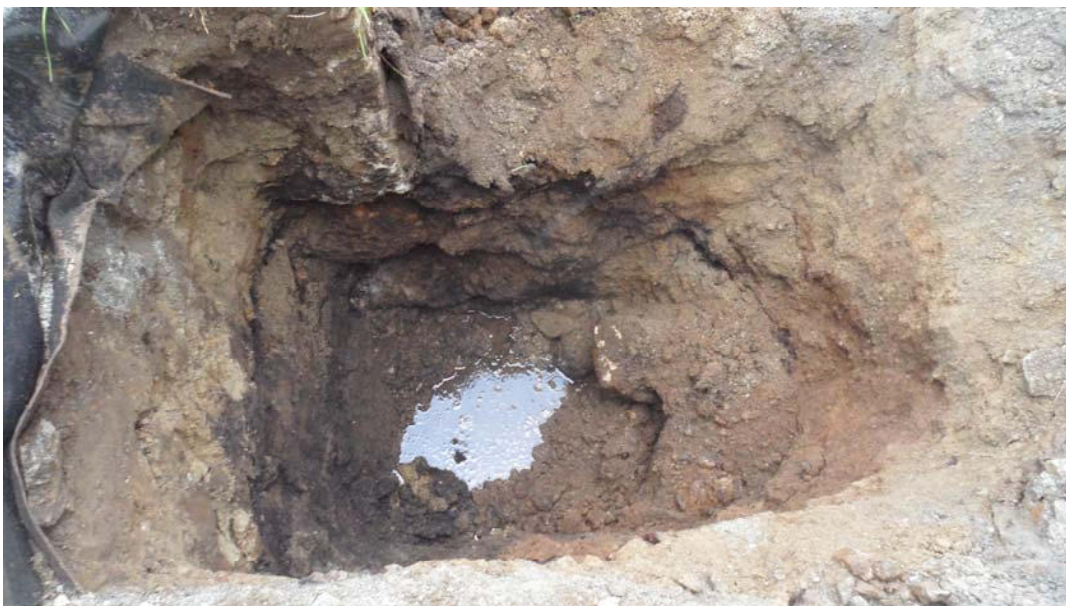
Bilde 3: Bildet viser grunnforholdene i sjakt 1 ved Løvstakkvatnet Sør.
