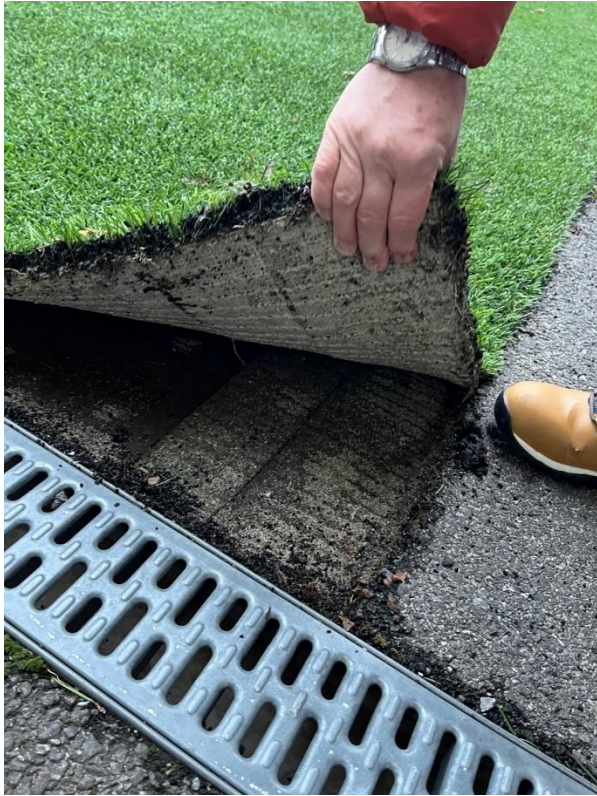
Figur 9 og 10 Fra hjørnet i nord-vest. Eksisterende kunstgress med pad. Ligger mot dreneringsrenne på kortsiden mot nord. Kunstgress system: Polytan, Liga Turf RS Pro II Cool Plus SBR 40mm med pad Recticel 14 mm. Hele systemet skal fjernes og avhendes ihht Forurensningsforskriften.
