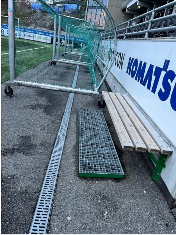
Figur 4 og 5 Tiltak for granulat på avveie. Rist med benk for å børste av seg granulat og evt skifte sko/strømper. Granulatfilter i alle overvannsluk
