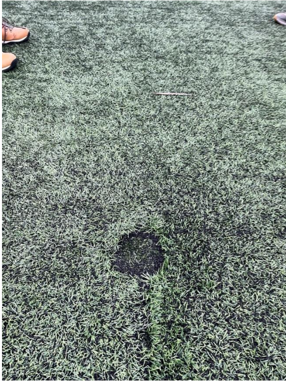
Figur 15 og 16 To spredere ute på banen som fjernes.
