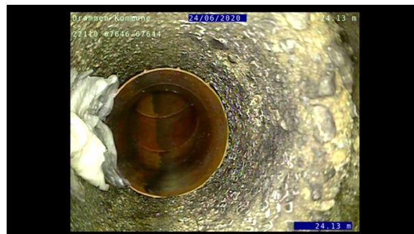
Foto: L67646_67644_22110_24062020_2_4_24,126_U.JPG, 00:04:56 24,13m, Tilkopling Kjerneboret tilkopling 09 Kl.
