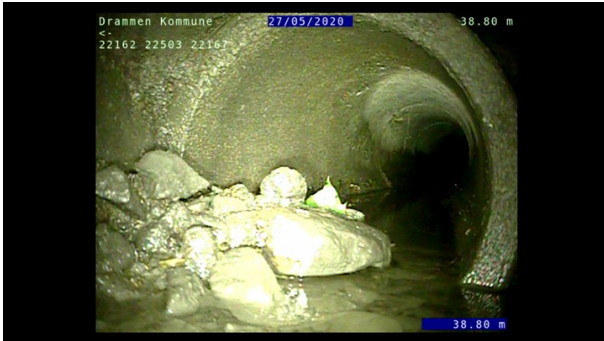
Foto: L22503_22167_22162_27052020_5_11_38,803_U.JPG, 00:06:28 38,8m, Inspeksjon fullført -
