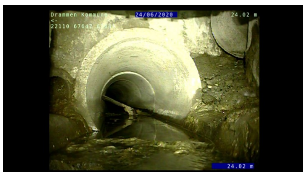
Foto: L67647_67644_22110_24062020_1_7_24,022_U.JPG, 00:07:48 24,02m, Inspeksjon fullført -
