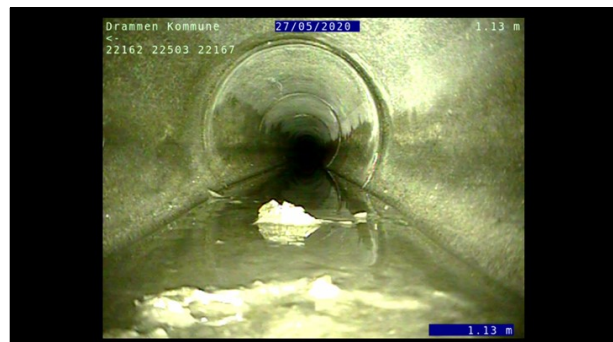
Foto: L22503_22167_22162_27052020_5_4_1,128_U.JPG, 00:00:23 1,13m, Sedimentering, dybde på avsetning er mellom 5-15%, 06 Kl., Fine masser (f eks sand, silt), Start
