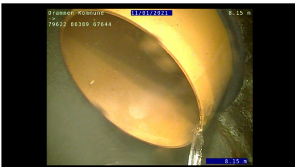
Foto: L86389_79622_67644_11012021_5_3_8,005_D.JPG, 00:02:17 8,01m, Tilkopling Kjerneboret tilkopling 03 Kl.
