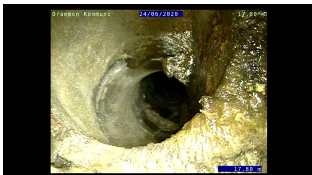
Foto: L67647_67644_22110_24062020_1_5_17,8_U.JPG, 00:03:41 17,8m, Tilkopling Kjerneboret tilkopling 03 Kl.
