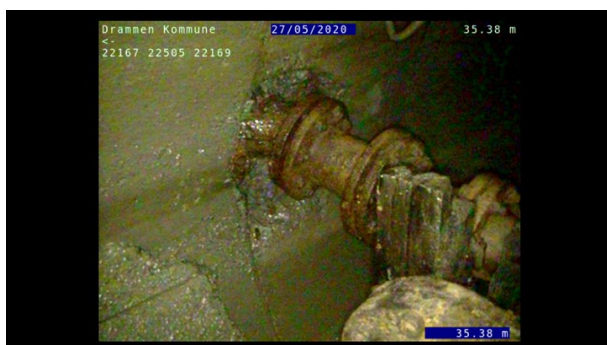
Foto: L22505_22169_22167_27052020_6_3_35,384_U.JPG, 00:04:58 35,38m, Inspeksjon fullført -
