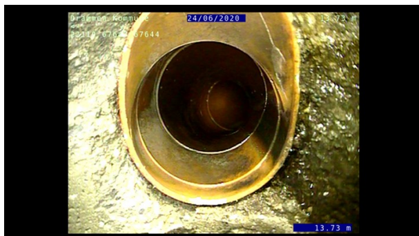
Foto: L67647_67644_22110_24062020_1_3_13,725_U.JPG, 00:02:24 13,72m, Tilkopling Kjerneboret tilkopling 02 Kl.
