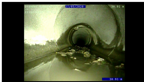
Foto: L22501_22161_22159_27052020_4_7_30,912_D.JPG, 00:03:05 30,91m, Sedimentering, dybde på avsetning er mellom 5-15%, fra 05 til 07 Kl., Grove masser (f eks stein, grus), Start
