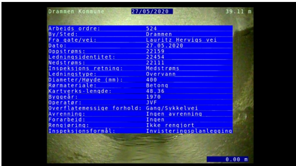
Foto: L22454_22159_22111_27052020_3_1_39,11_D.JPG, 00:00:00 0m, Start inspeksjon -
