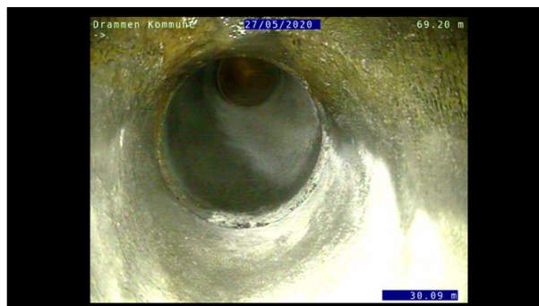
Foto: L22454_22159_22111_27052020_3_6_30,088_D.JPG, 00:03:58 30,09m, Tilkopling Prefabrikkert grennrør. 12 Kl.
