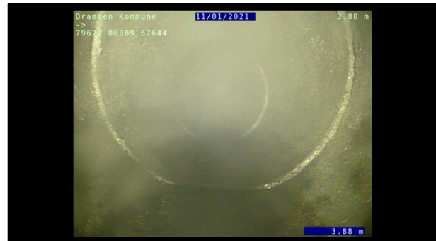
Foto: L86389_79622_67644_11012021_5_2_3,88_D.JPG, 00:01:25 3,88m, Materialendring til Betong
