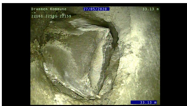
Foto: L22501_22161_22159_27052020_4_8_33,134_D.JPG, 00:03:37 33,13m, Tilkopling Innhugget tilkopling 10 Kl.
