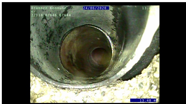
Foto: L67646_67644_22110_24062020_2_3_13,401_U.JPG, 00:02:37 13,4m, Tilkopling Kjerneboret tilkopling 02 Kl.
