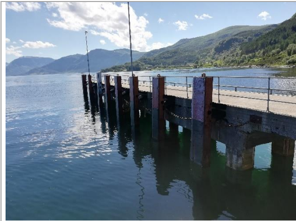
Bilde 17: Fenderelement på kai
