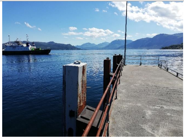
Bilde 18: Fenderelement på kai.
