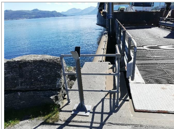
Bilde 7: Nyere betong
