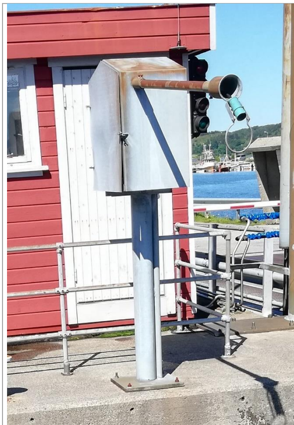
Bilde 11: Nødstrømtrommel og trafikklys.
