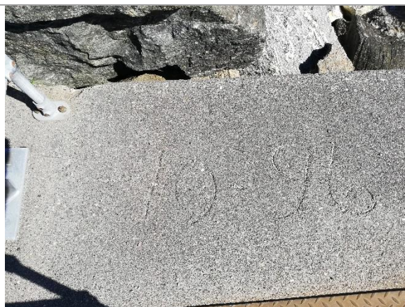
Bilde 8: Prøvepunkt nyere betong
