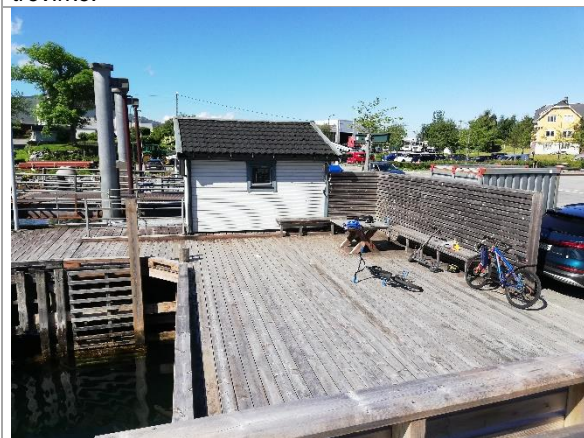
Bilde 9: Nyere trekai med trykkimpregnert trevirke. Starter ved stige ned til sjø.
