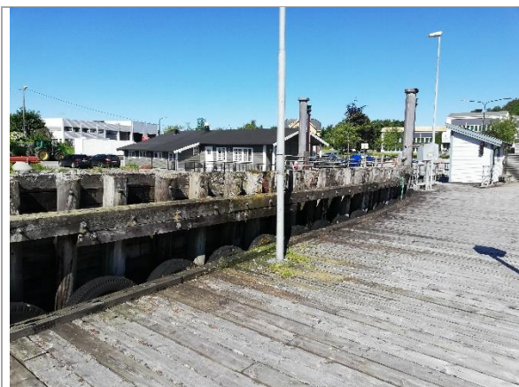
Bilde 14: Kreosotbehandlet støttevegg til ferge.
