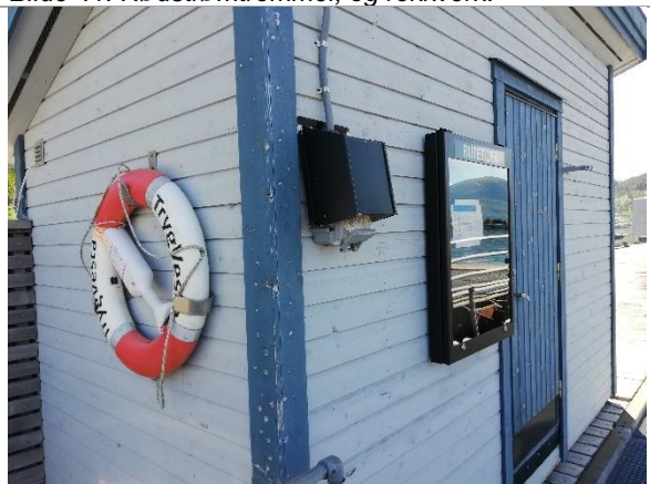
Bilde 43: Redningsbøye og rutetidskap på aggregathus.
