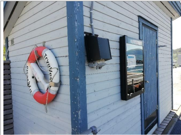
Bilde 24: Strømuttak på aggregathus.
