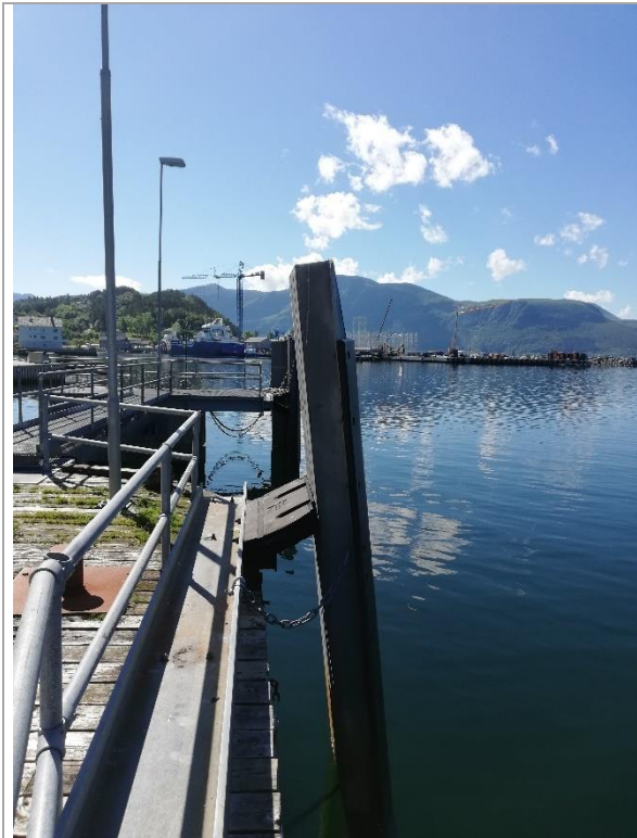
Bilde 30: Fenderelement på trekai.
