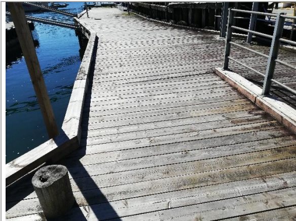
Bilde 7: Overgang mellom kreosot- og trykkimpregnert trevirke.
