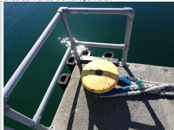
Bilde 32: Fenderlister og innstøpt pullert.
