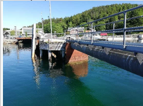
Bilde 28: Stålplate ytterst på trekai.
