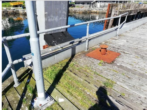
Bilde 37: Pullert, rekkverk og stålbjelke
