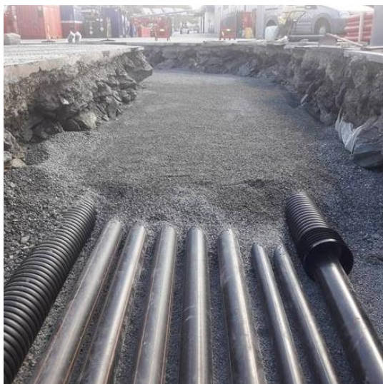
Figur 4: Eksisterende rørtrase som skal krysses
